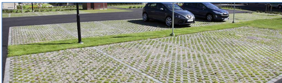
Figur 7-2. Parkeringsplats för bil utförd med gräsarmering som möjliggör för högre infiltration och mindre dagvattenavrinning (Blenders, 2025).
