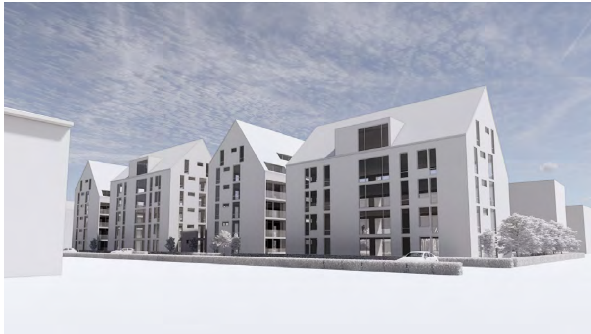
VY FRÅN RUNDELSGATAN MOT SYDOST
