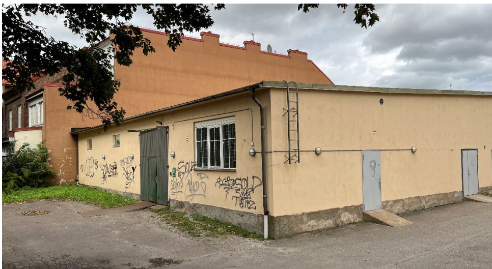
Figur 3. Baksidan av den befintliga byggnaden inom planområdet.
