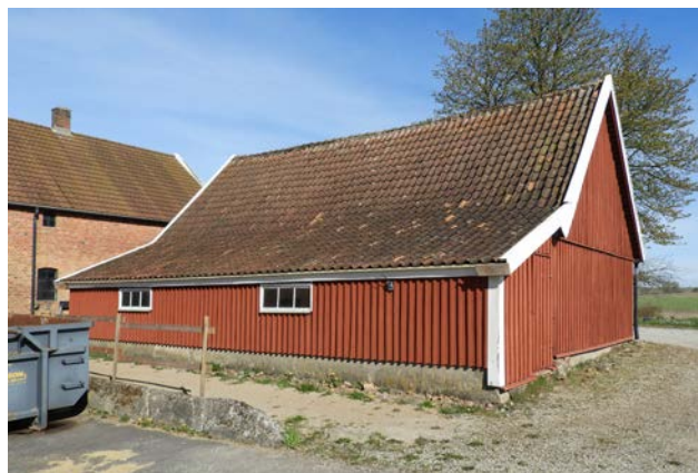
Traktorgaraget sett från söder.
