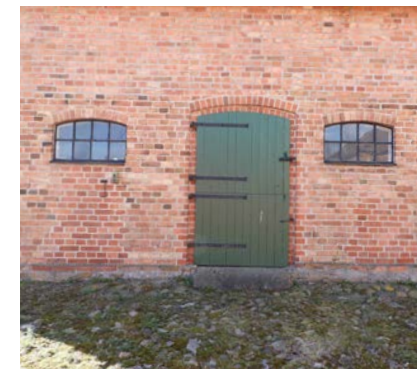
Detalj av norra fasaden, utgång mot gödselstacken. Under fönstren syns igenmurade luckor för grisarna.
