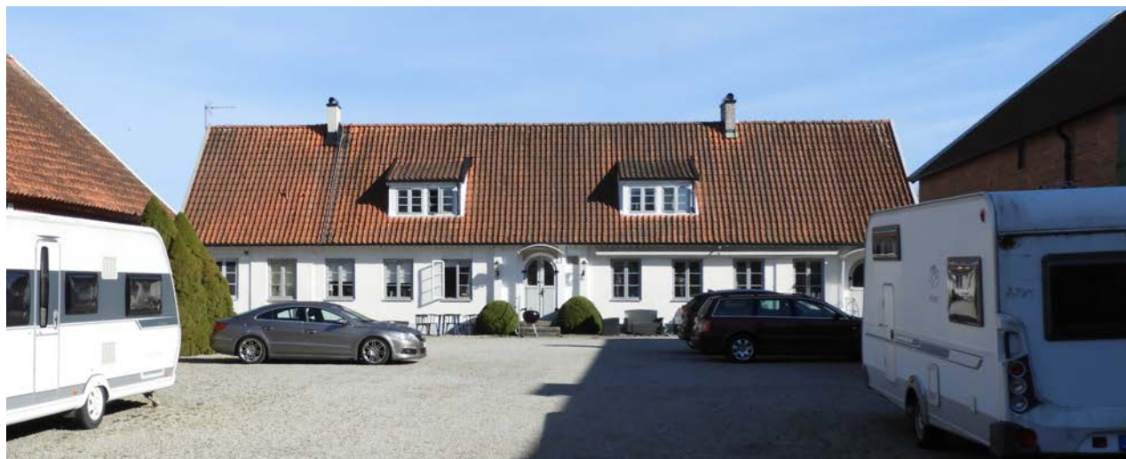
Mangårdsbyggnadens fasad mot gårdsplanen i söder.
