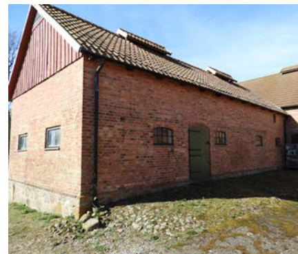
Svinstallets norra fasad och östra gavel.
