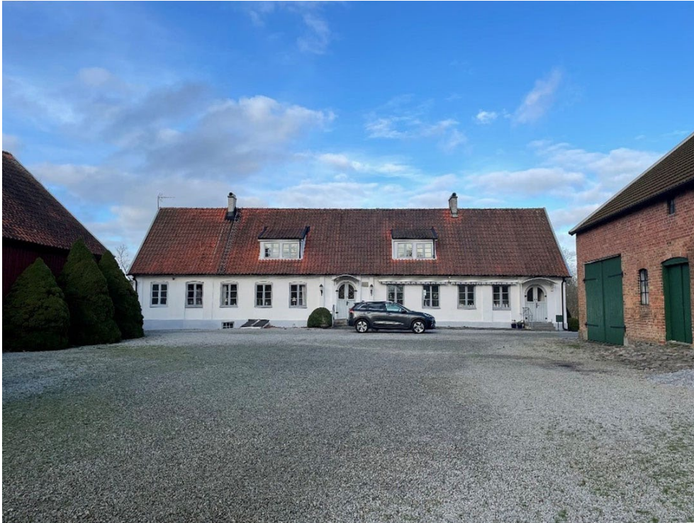
Figur 8. Mangårdsbyggnaden och gårdsplanen sett från söder.
