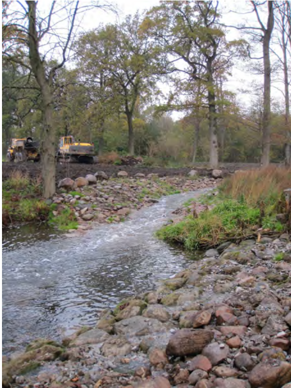
Figur 4.13: Passagen förbi dämnet i Bråån vid Örtofta slott gör att till exempel lax och öring kan simma upp i Bråån och leka om de tagit sig förbi hindren i Kävlingeåns huvudfåra.
