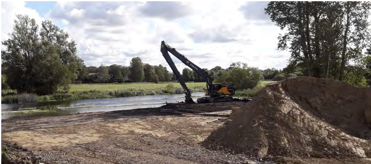
Figur 4.9: Pågående sanering, tidig höst 2019, av den kraftigt förorenade fastigheten vid Kävlingeån i Getinge, Eslövs kommun
