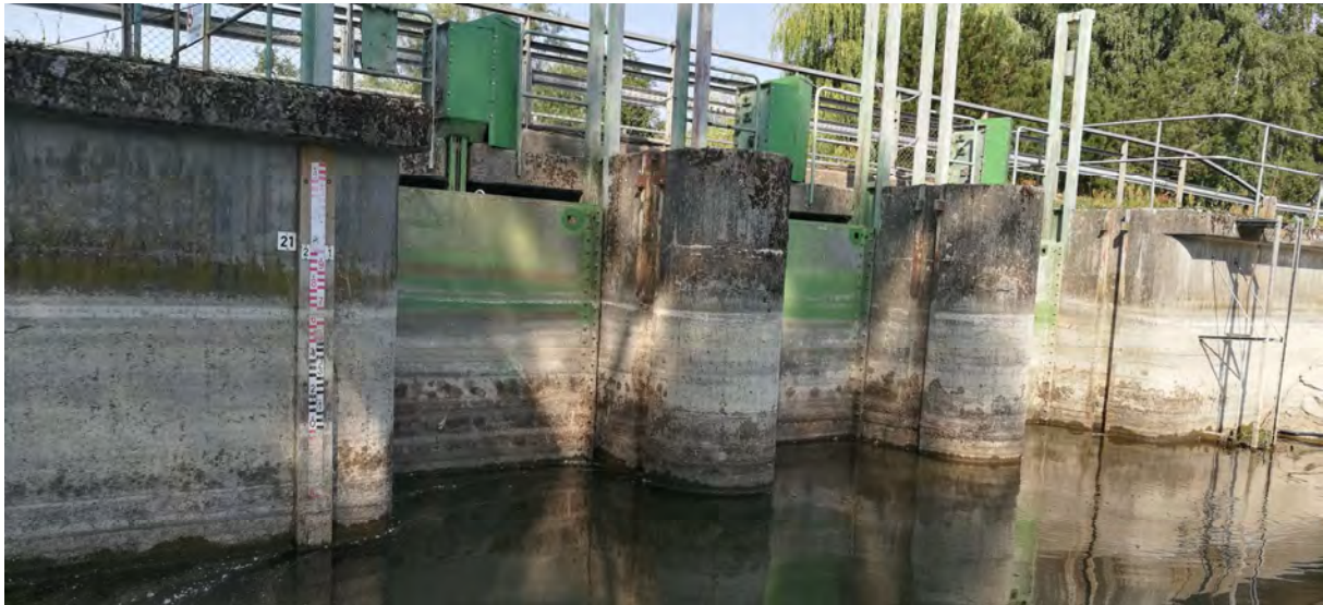
Figur 4.5: Regleringsdammen vid Vombsjöns utlopp i Kävlingeån från uppströmssidan i Vombsjön.
