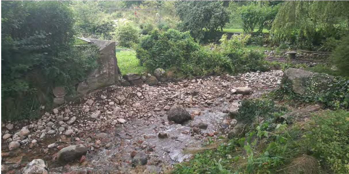
Figur 4.14: Vid Skönadals kvarn i Harlösa har ett vandringshinder för fisk och andra vattenlevande organismer rivits ut inom ramen för arbetet med Kävlingeåns vattenvårdsprogram.
