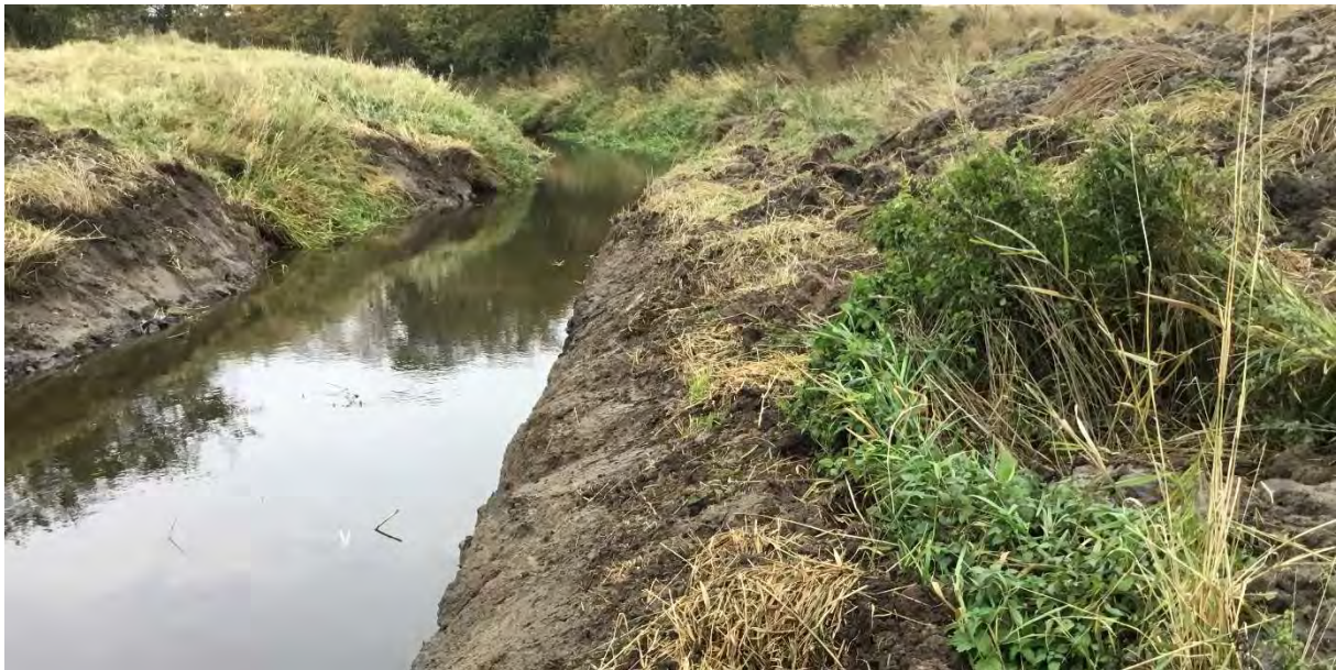
Figur 9.1: Vattendrag som utgör dikningsföretag karakteriseras ofta av att de är djupt nedskurna, har branta kanter och är raka. Bilden visar en nyligen rensad sträcka av Bråån.
