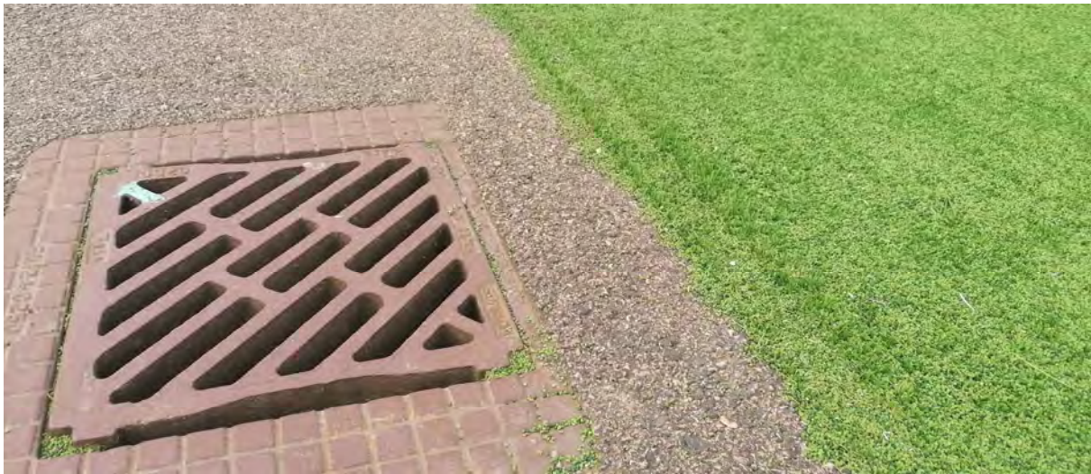
Figur 7.5: Granulater från konstgräsplaner kan sköljas bort från planerna och ner i dagvattenbrunnar. Problemet kan delvis avhjälpas med uppsamlare i brunnarna.
