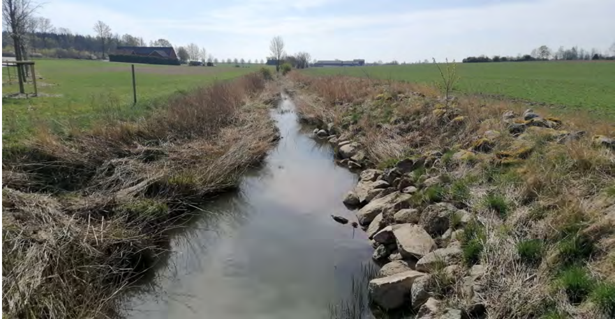
Figur 9.6: Saxån strax söder om Farstorp är ett typiskt dikningsföretag som karaktäriseras av att vattendraget är uträtat och fördjupat.
