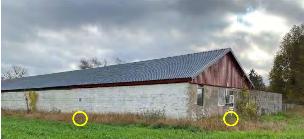
Figur 52. Foto på byggnaden där veterinärkliniken har sin hästmottagning, sett från nordväst. Gul markering visar var luftvärmepumpen och ventilationsuttaget finns.
