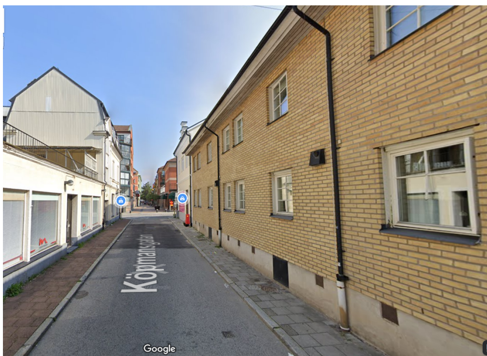
Gatubild söderifrån aktuell fastighet till höger
