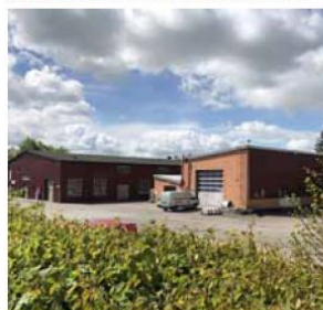
1. Blästringsverkstad, Gamla Engson samt trycksakverksad, i trä
