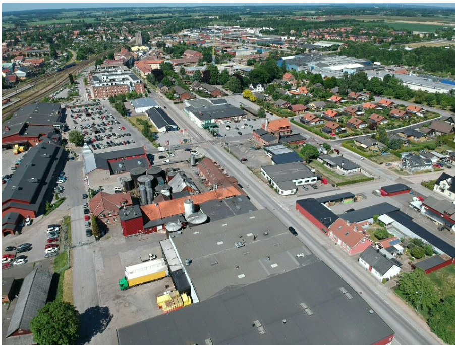
Figur 2.3 Centralt i bilden syns anläggningarna där ammoniak och etanol hanteras. Av bilden framgår hur dessa anläggningar är väl skyddade och kringliggande bebyggelse bidrar till att begränsa en spridning.
