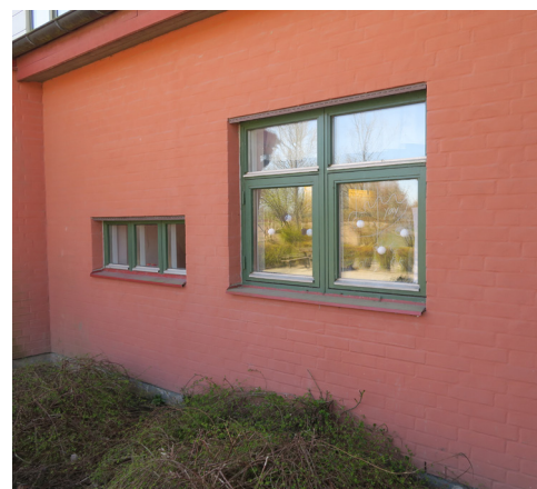
Detalj av fasad med fönster på norra längan.
