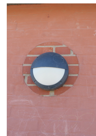
De ursprungligen bara tegelväggarna har senare slammats. Vid fasadarmaturer syns det ursprungliga utseendet.
