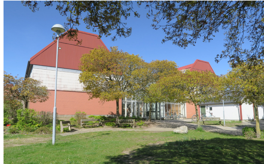
Södra och norra längornas östra gavelfasader, med den mellanliggande glasgången.
