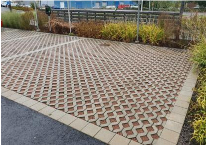
Figur 17. Exempel på permeabla ytor (Tyréns, 2021).
