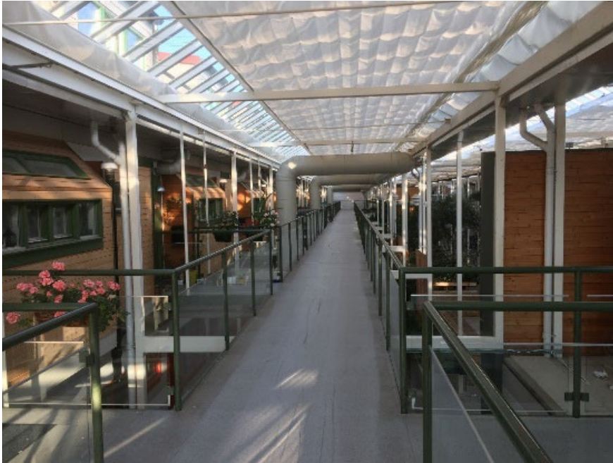
Figur 17. Inre loftgång i den befintliga byggnaden
