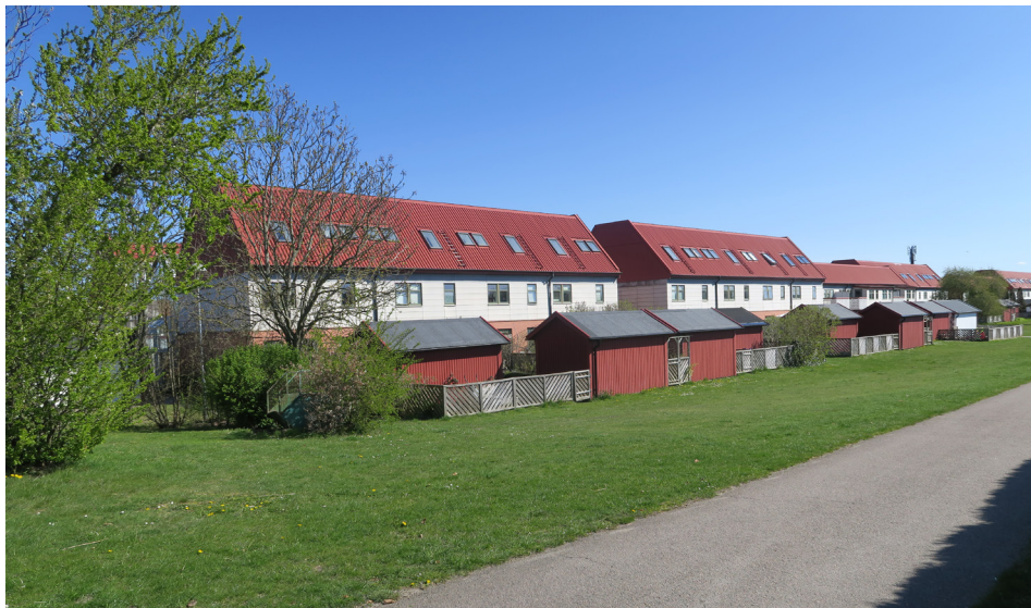
Södra längans fasader mot söder.
