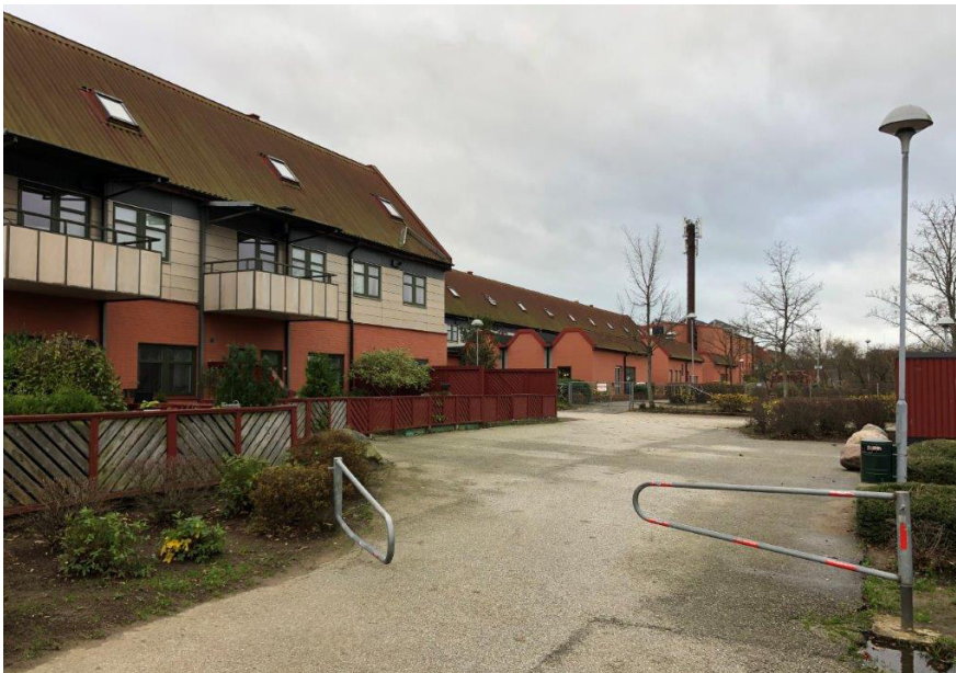
Norra längan, vy mot väster.
