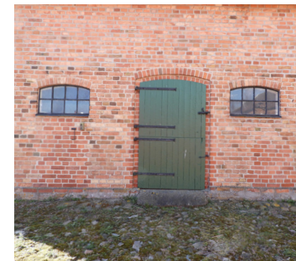
Detalj av norra fasaden, utgång mot gödselstacken. Under fönstren syns igenmurade luckor för grisarna.
