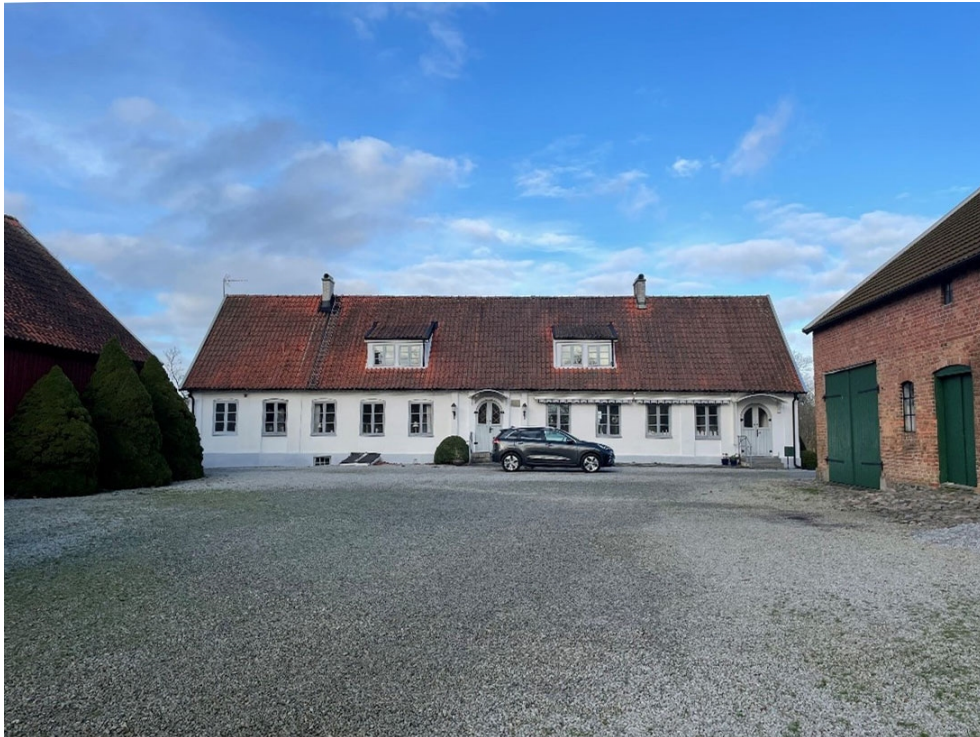
Figur 8. Mangårdsbyggnaden och gårdsplanen sett från söder.
