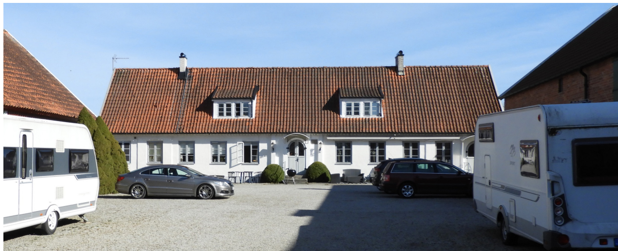
Mangårdsbyggnadens fasad mot gårdsplanen i söder.
