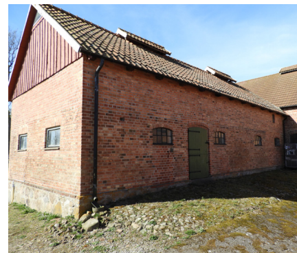
Svinstallets norra fasad och östra gavel.
