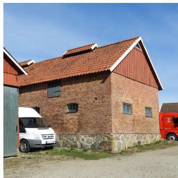
Svinstallets södra fasad och östra gavel.
