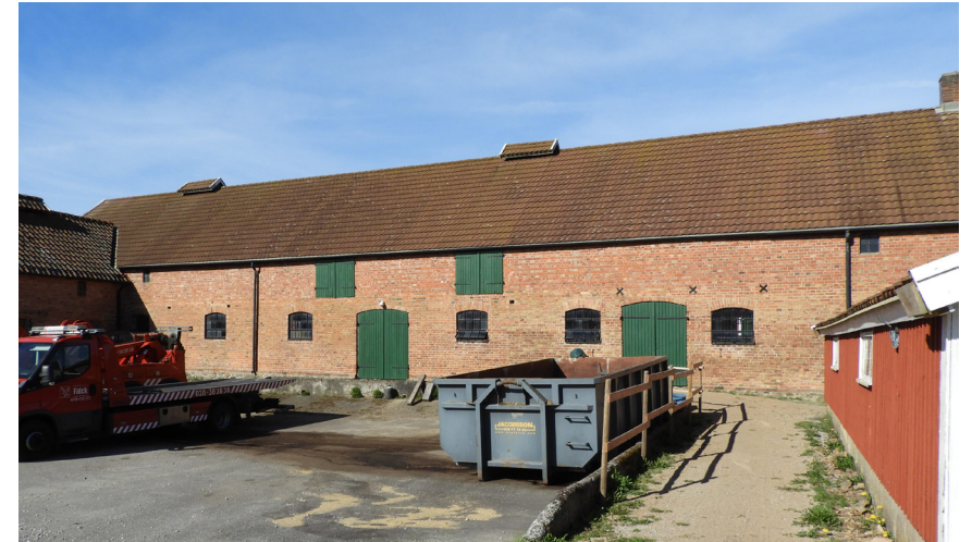
Kostallets fasad mot öster med gamla gödselplattan i förgrunden.
