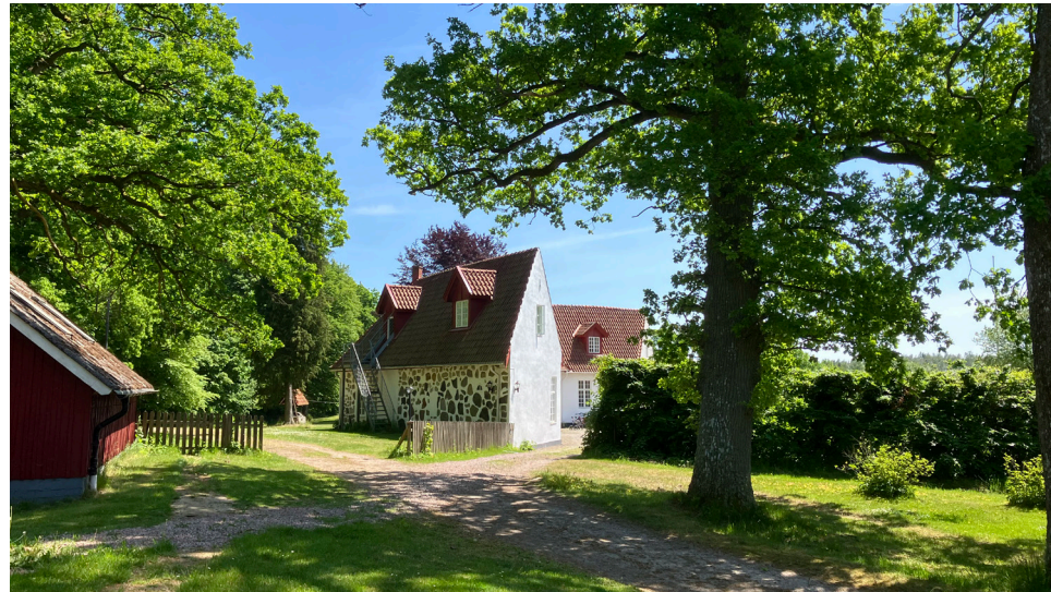
Borgen. Vy över den nordvästra delen av byggnaden.
