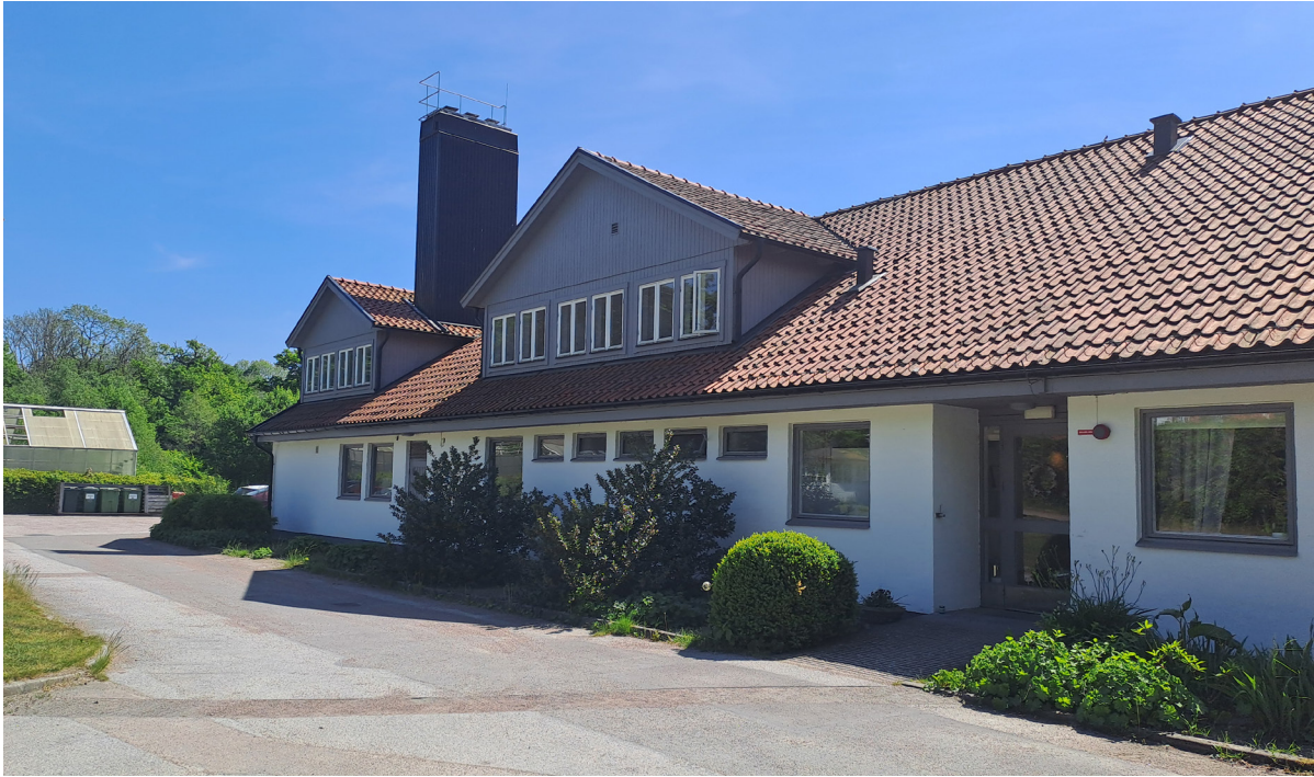
Trädgårdsvillan som hyrs ut för behandlingshem. Framsida/entré på byggnadens norra sida.
