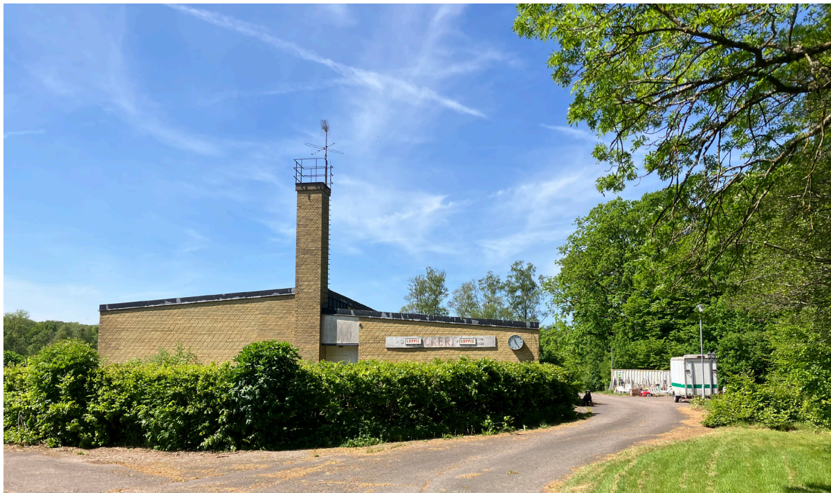
Industribyggnad med befintlig loppisverksamhet, den östra gaveln.
