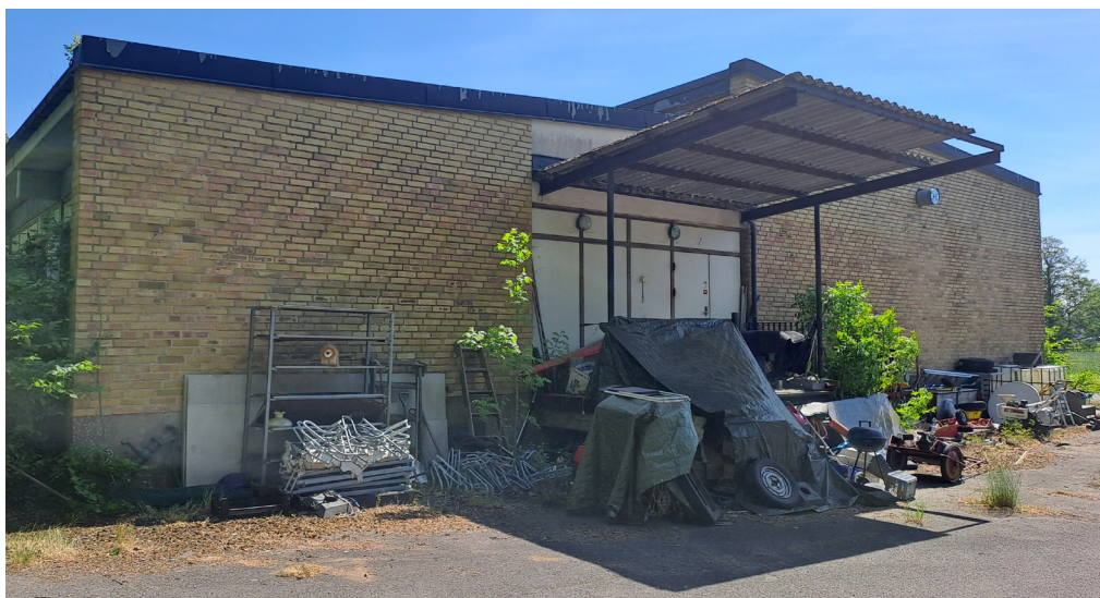
Industribyggnaden, den västra gaveln.
