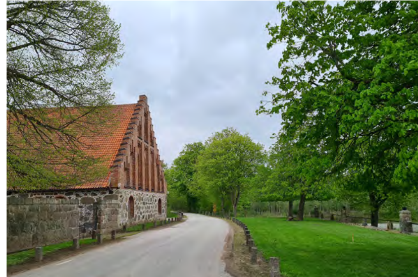
Ladugårdsplatsens stenbyggnader som kantar infartsvägen härrör från 1800-talets andra hälft och uppfördes efter ritningar av C G Brunius. Hans medeltidsinspirerade formgivning märks i gavelpartiernas och omfattningarnas tegelmurverk.
