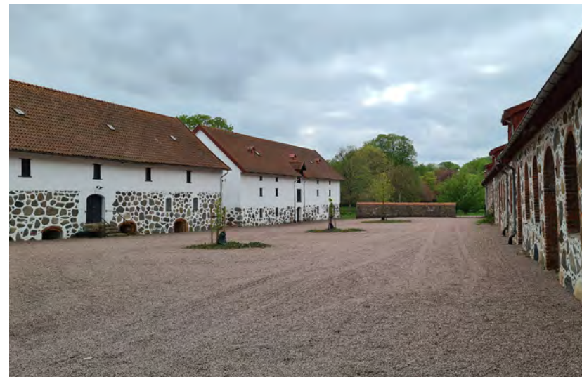
Söder om ladugårdsplatsen ligger ytterligare ekonomibyggnader varav åtminstone det närmast i bild delvis härrör från 1700-talet.
