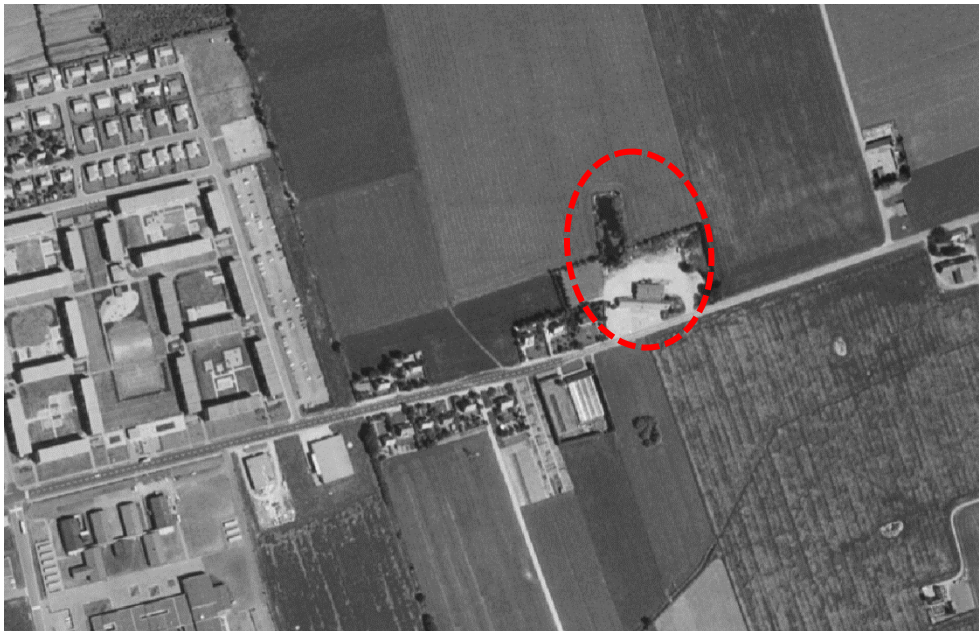
Flygfoto från cirka 1975. Det går att urskilja den befintliga mörgelgraven inom rödmarkerat område. Tidigare gård har ersatt med bostäder, handel och småindustri.
