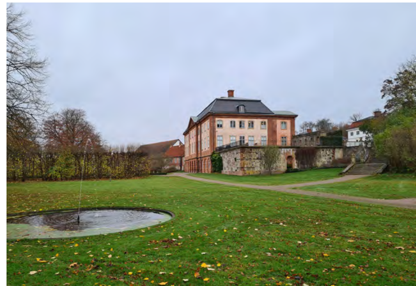
Den för Övedskloster karakteristiska lokalt brutna röda Övedssandstenen präglar huvudbyggnaden, men förekommer även i andra byggnader som tex Voliären.
