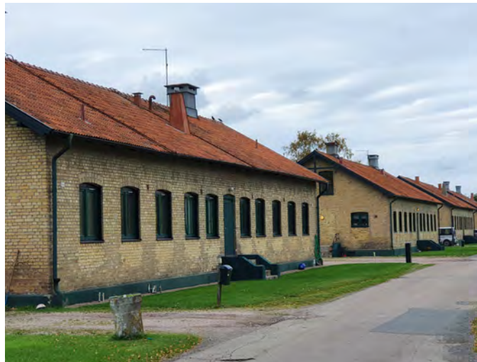
Arbetarbostäder till det tidigare sockerbruket i Araslöv.
