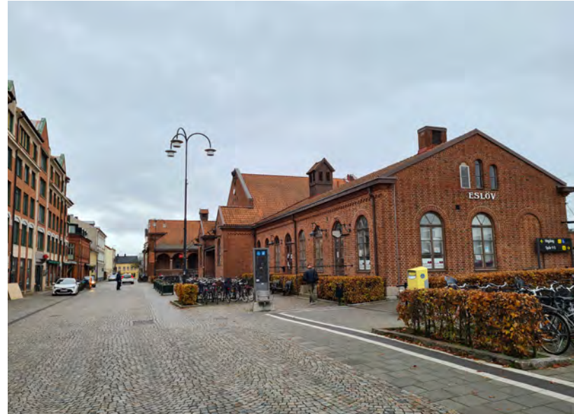
Den gradvis utbyggda stationsmiljön med ursprung från 1866 präglas främst av om- och tillbyggnader i början på 1900-talet.
