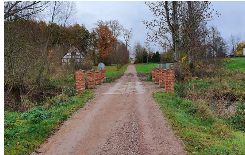
Bro över Braån som leder till arbetarbostäder på den tidigare bytomten.
