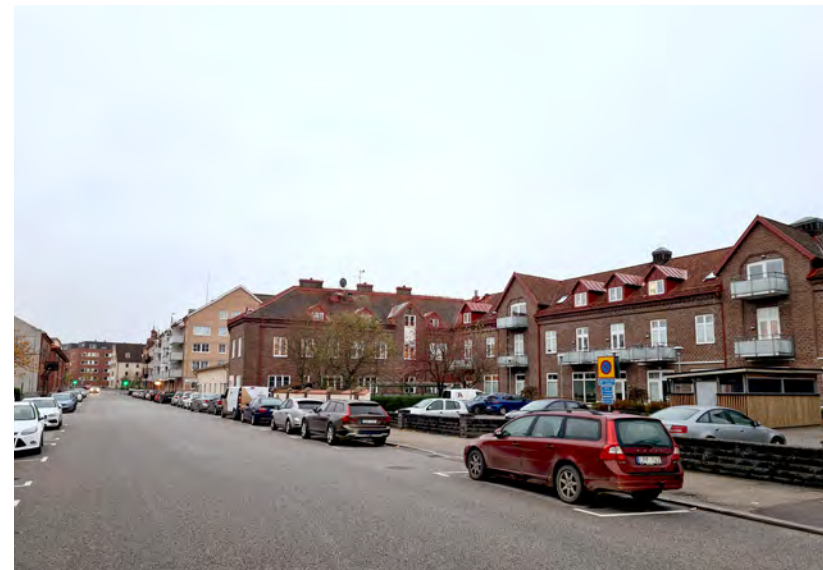
Utmed Kvarngatan ligger den tidigare mejerianläggningen som stod klar 1919 och inrymde mejeri, kontor och disponentbostad.
