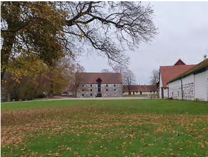
Ladugården och äldre magasinbyggnad i slottsmiljön.
