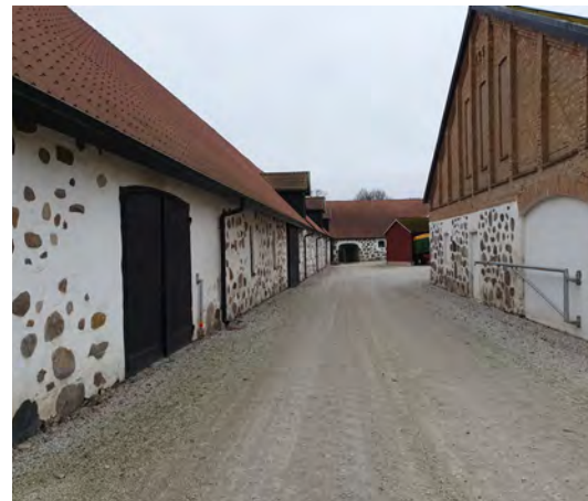
Trollenäs storskaliga ekonomibyggnader i gråsten och rött tegel.
