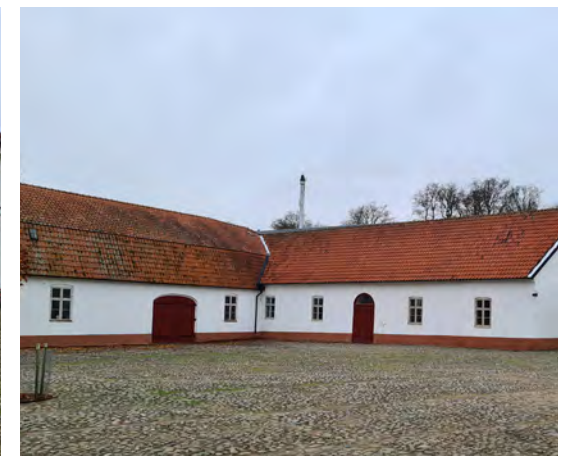
Godsets ekonomibygnader ligger samlade väster om slottet. Herrskapsstallet skärmar av slottet från ladugårdsplatsens mer blandade bebyggelse.
