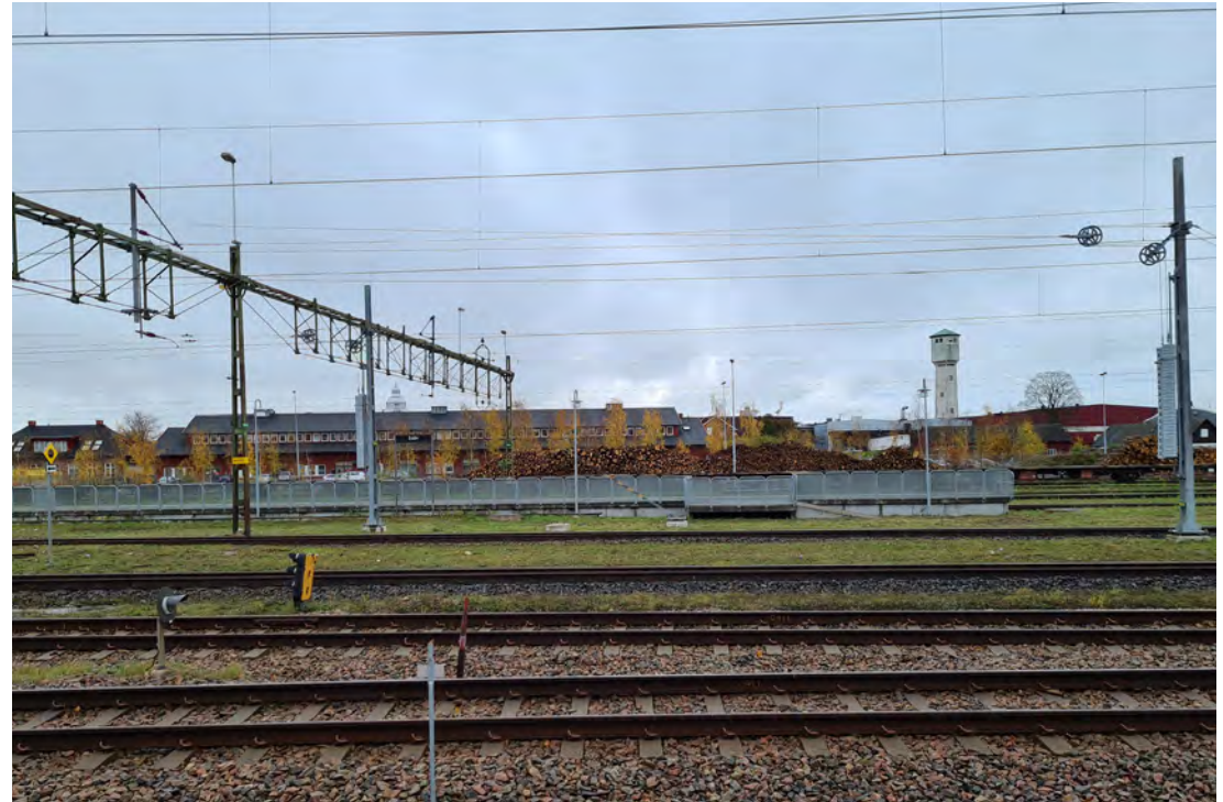
Industriområdet öster om järnvägen är fortsatt närvarande i stadsbilden från stationsområdet och Storgatan. Vattentornet höjer sig i fonden och strax söderut, just utanför bild framträder även lagerhuset.
