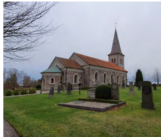
Västra Strös nya kyrka uppfördes på 1870-talet.
