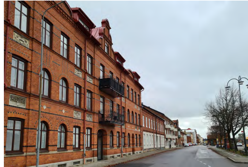
Storgatan som löper parallellt med järnvägen kantas av representativ tegel- och putsarkitektur från 1800-talets slut och 1900-talets början.
