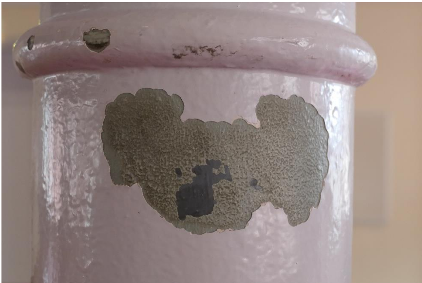
Gjutjärnskolonnen visar tidigare färgskikt i grågrön kulör.
