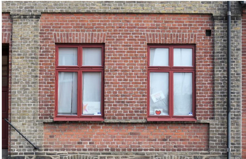
Vänster foto från 1970-talet visar ursprungligt fönster. Idag är fönstren utbytta till nya, utformade likt de ursprungliga med korspostindelning och utåtgående bågar.
