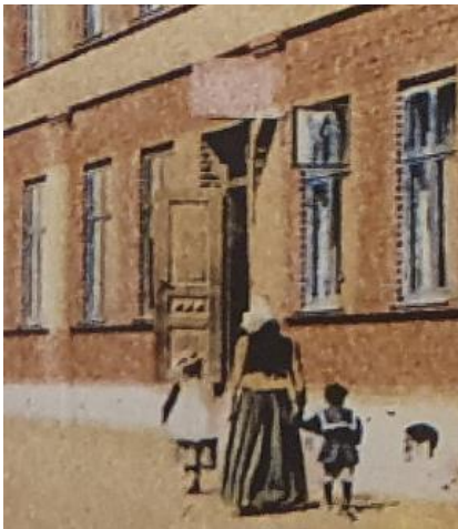
Beskuret foto från omkring sekelskiftet 1900 visar insidan av den ena pardörrens dörrblad samt de ursprungliga fönstren. Dörren har tre speglar varav den mittersta med romber.
