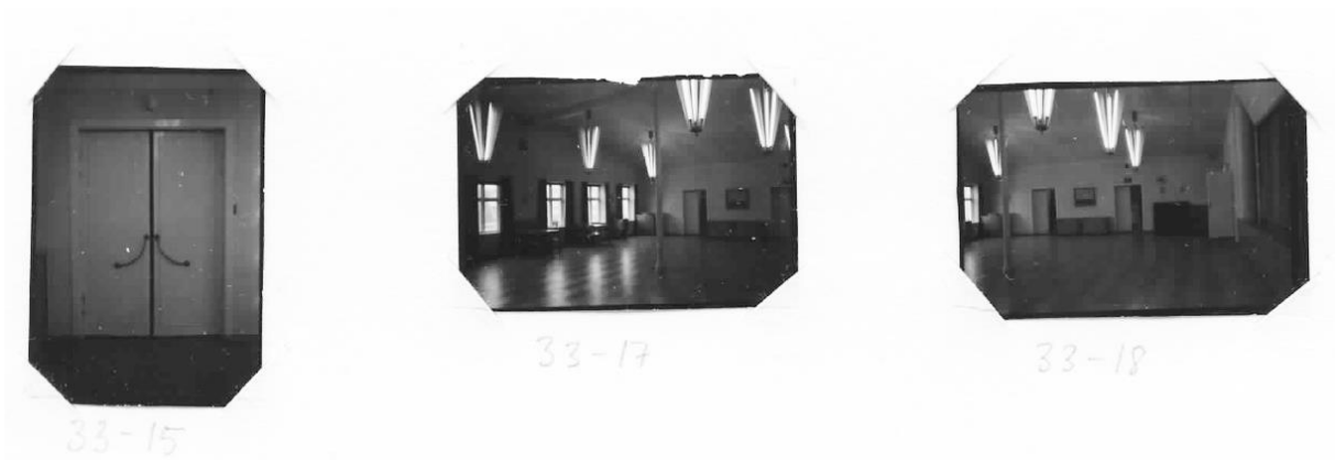
Interiöra fotografier som visar salongen på andra våningen. Till vänster syns en svängdörr med två dörrblad som idag är ersatt med en pardörr med nödutgångsfunktion.
