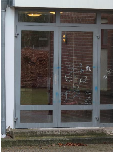
Glasdörrar från 1990-talet på gårdssidan.
