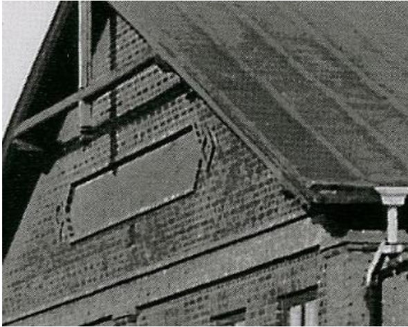
Ursprungligen var taket täckt med papp, bild t.v. från ca 1909. Idag är taket klätt med korrugerad plåt.
