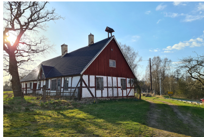
Korsvirkesbyggnad vid Bålamöllan.
