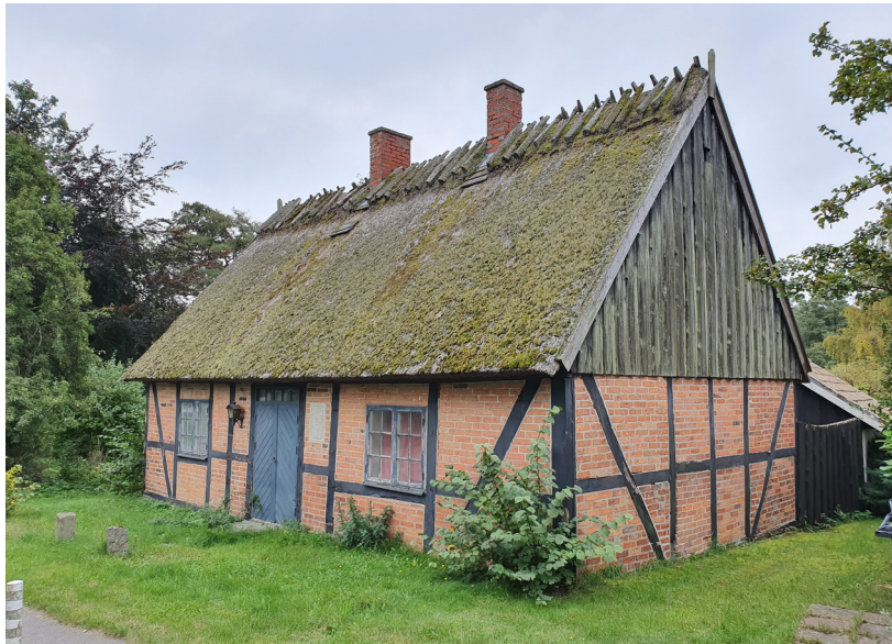
Här ett gatehus i Sövde i Sjöbo kommun med bränd tegel och korsvirke till skillnad mot det ovan putsade lerfacken i korsvirket där man ofta hade lertegel dvs obränd lera. Leran grävdes upp från marken och slogs i träformar, lades att torka, putsades och kalkades.
