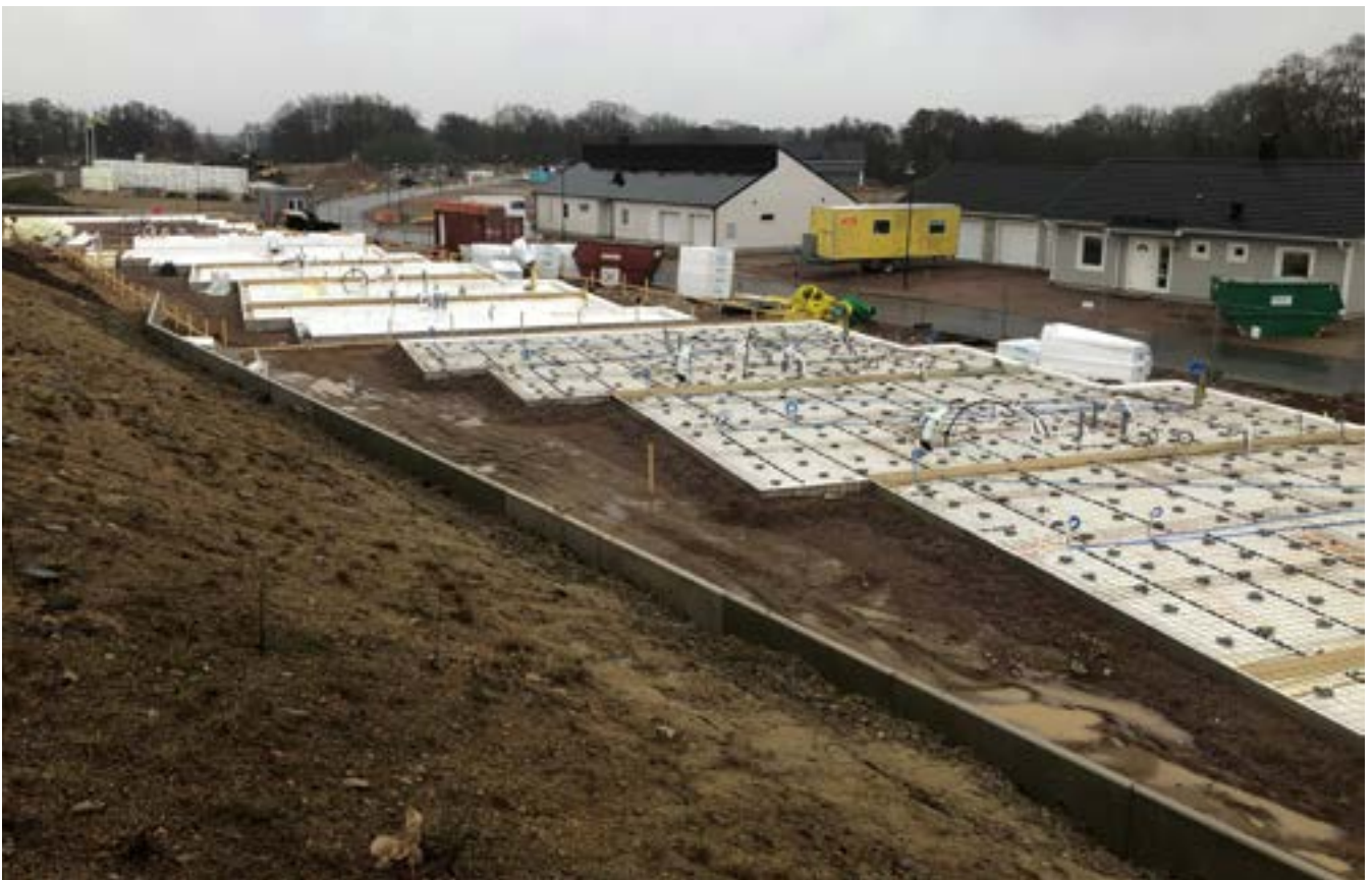
Figur 6. Nybyggnation av flerbostadshus i västra Höör
