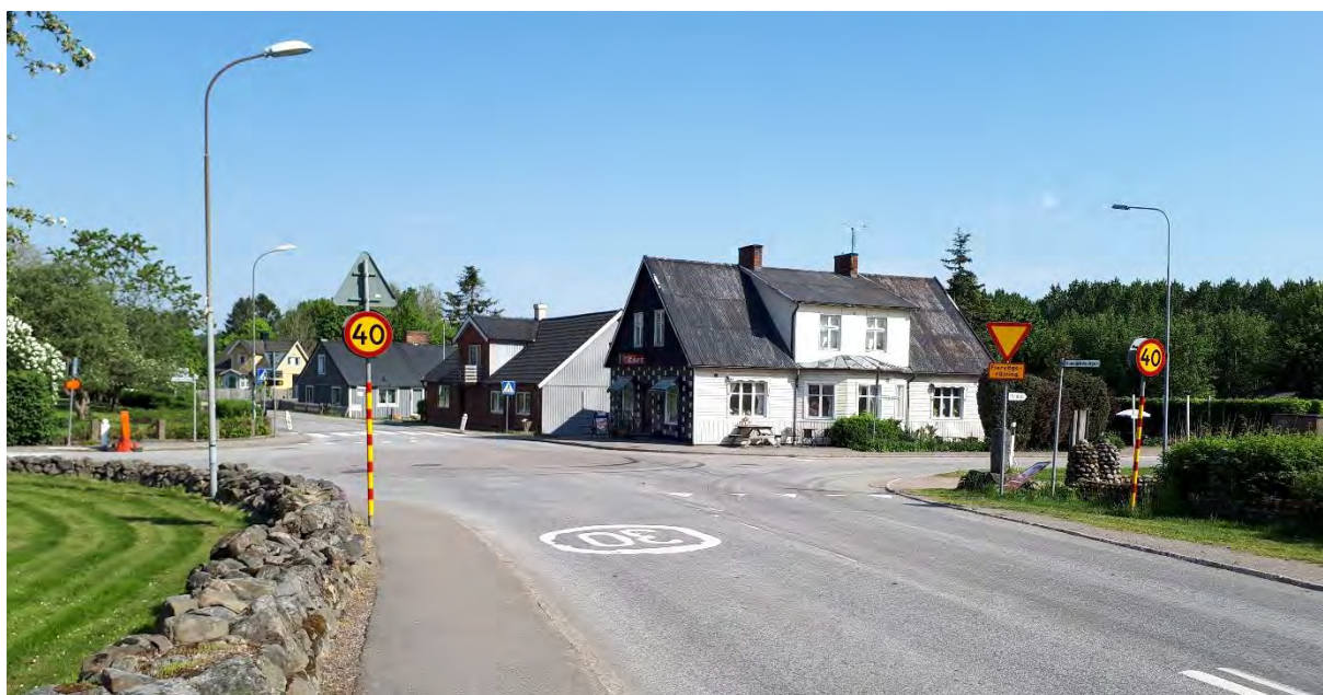
Figur 9. Fyrvägsväjning med rondellyta.
