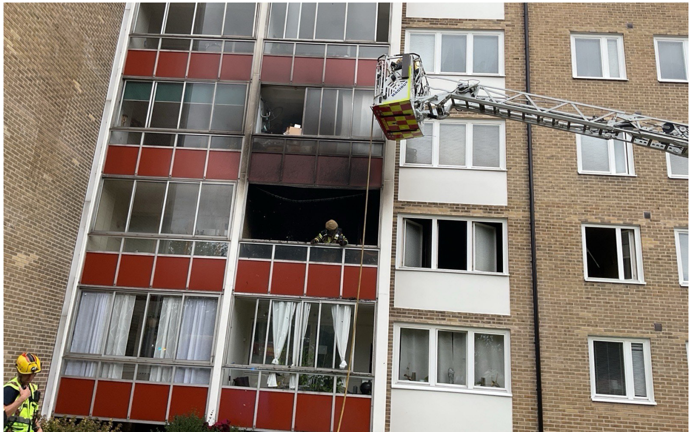
En brand i ett flerfamiljshus med spridning till flera brandceller via balkongen.
