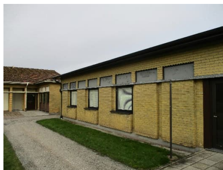
Fasad byggnad A & B
