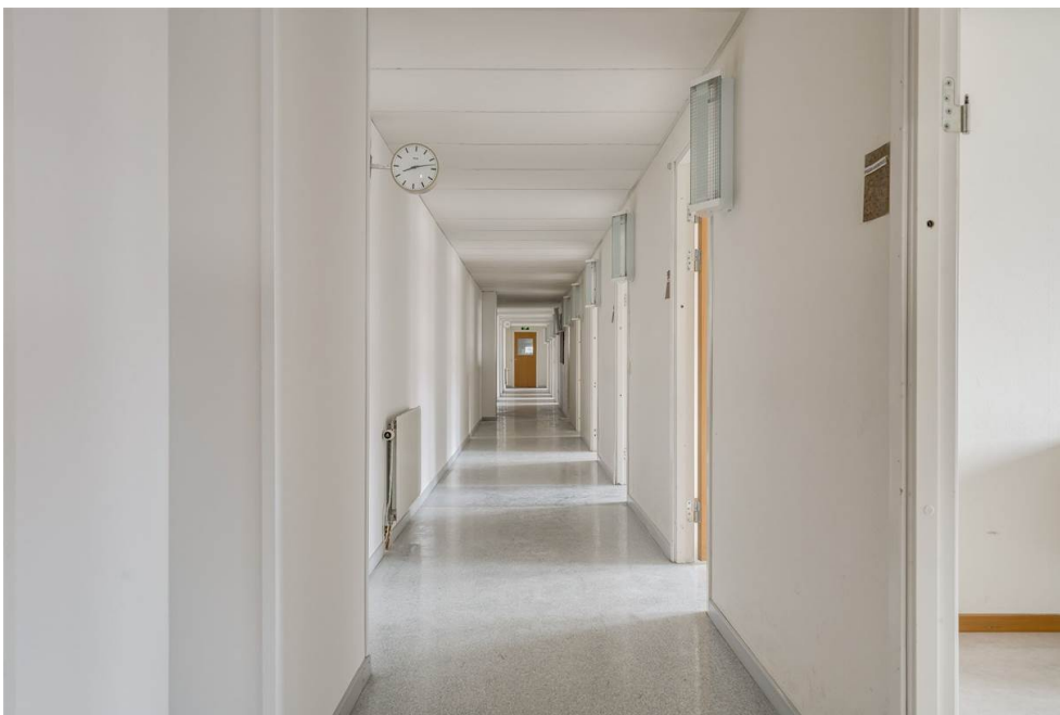
Figur 8 Korridor till kontorsrummen i byggnaden från 1985.
