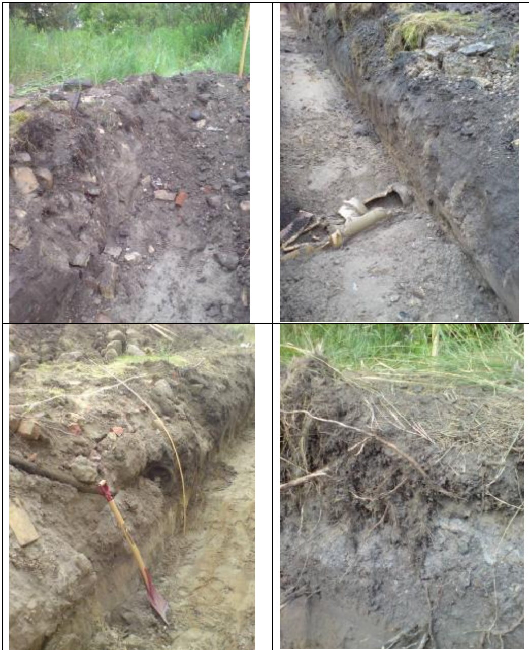
Figur 7 Foton från grävning inom det f d fabriksområdet. Överst till vänster: fyllning innehållande mulljord, tegel. Överst till höger: ledning. Nederst till vänster: fyllning med bland annat tegel, en ledning skymtar i bilden. Nederst till höger: fyllningen är täckt av ett tunt växtskikt.
