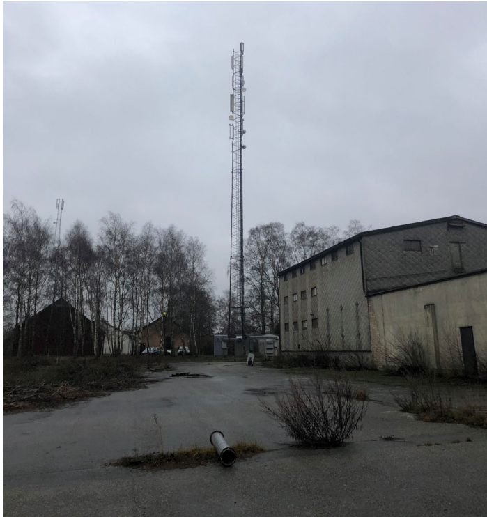
Masten som står på grannfastigheten Östra Gårdstånga 2:65.
