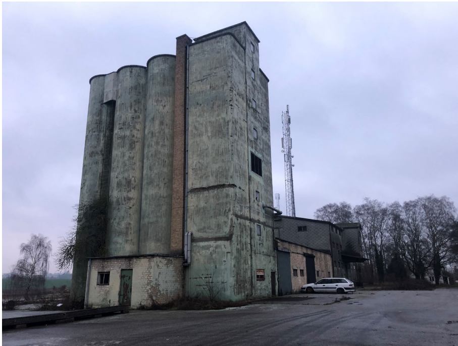
Vy över silon och industribyggnaderna inom planområdet.
