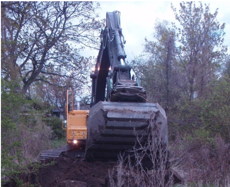
Figur 21: Schakt med grävmaskin
