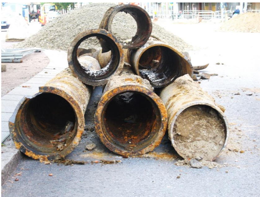
Ledningsnätet åldras och måste förnyas
