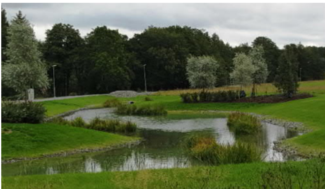
Figur 12: Damm med permanent vattenspegel. Dagvattengrupp 2019.
