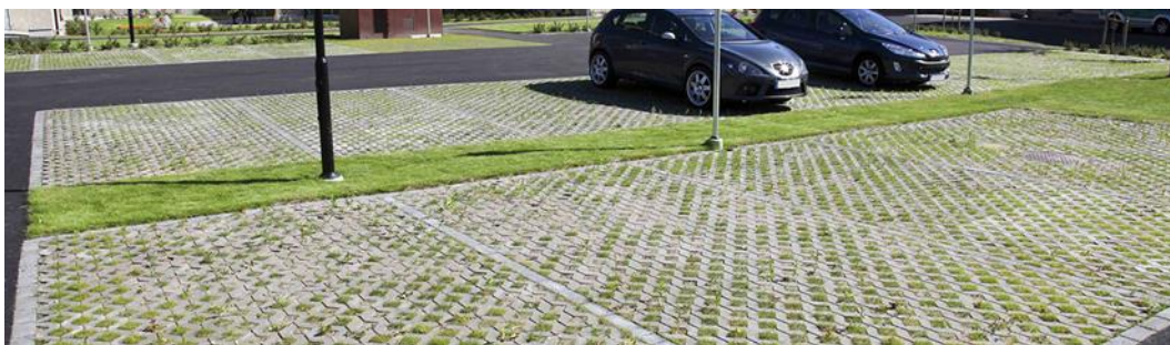
Figur 7-1. Parkeringsplats för bil utförd med gräsarmering som möjliggör för högre infiltration och mindre dagvattenavrinning (Benders 2019).
