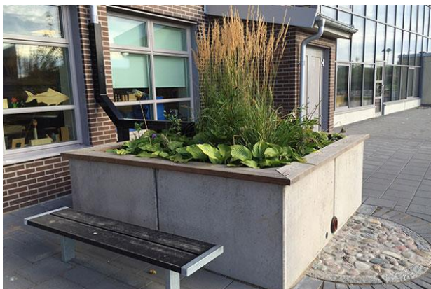
Figur 7-3. Upphöjd regnbädd ovan mark som även kan användas för till exempel plantering eller odling (Bara Mineraler 2019).
