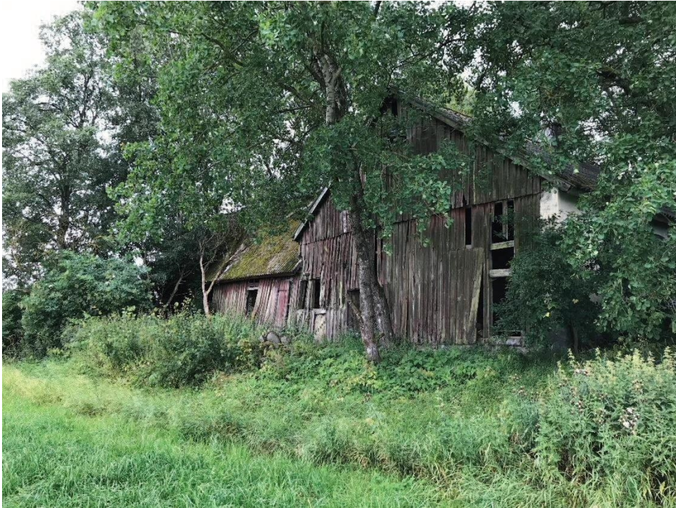
Norra fasaden, del av ladugård. Bostadsfasaden skymtas till höger i bild. Juli 2020.
