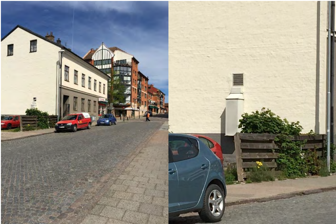
Figur 6. Utblås placerat på vägg på Bryggaregatan. Till höger närbild på utblås.
