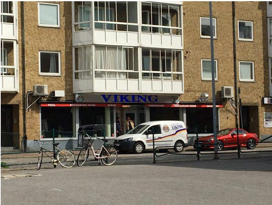
Figur 4. Tre värmepumpar finns placerade på fasad på Södergatan i direkt närhet till planområdet.
