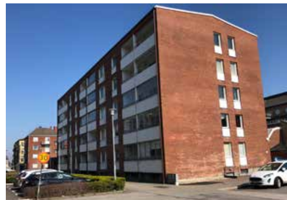
Garvaren 16 är ett lamellhus i rött tegel uppförd tidigt 1960 tal. På samma sätt som för Färgaren 21 är byggnadens entréer ej vända mot Kanalgatan.
