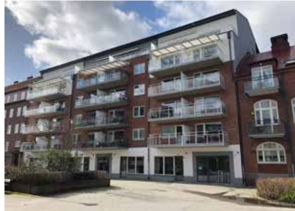
Målaren 8 uppförd under 2010-talet i rött tegel med bottenvåning i gråvit puts. Byggnaden har 5 våningar och en indragen 6:e våning. Nockhöjden är den samma som Målaren 5 till vänster.
