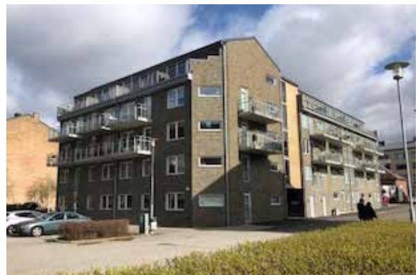
Färgaren 21 uppförd under 2010-talet i grått fasadskiffer. Byggnaden utmärker sig formmässigt tillsammans med Målaren 8 med en indragen översta våning.
