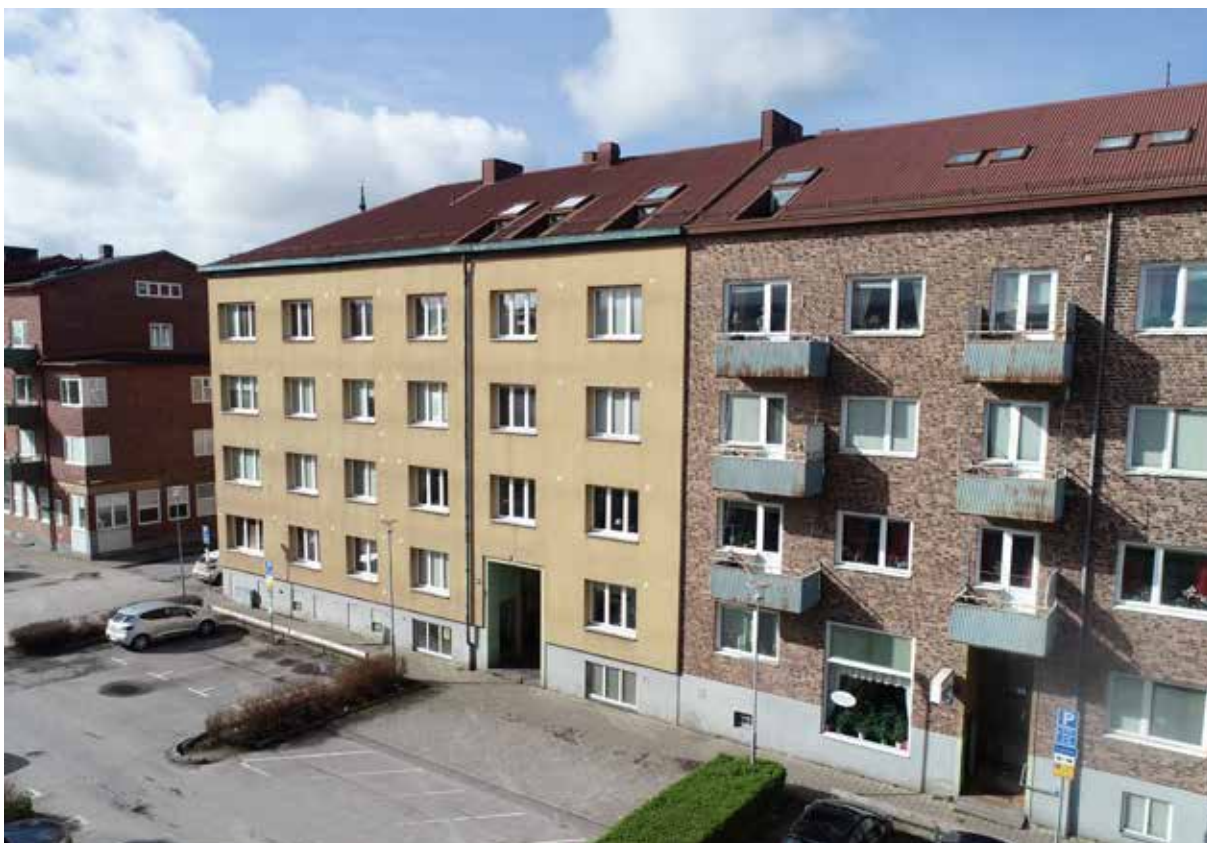
Skomakaren 9 och 15, uppförda under tidigt 1940-tal. Skomakaren 9 till vänster med gul puts och tilläggsisolering, troligen genomförd under 1970-talet. Skomakaren 15 till höger med rödbrunt tegel.
