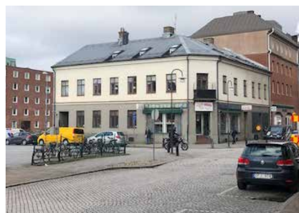
Garvaren 14 är ett gathus uppfört i två våningar under 1890-talet. Tegelmurad fasad med bottenvåning i grå puts. Publik verksamhet i bottenvåning med avfasat gathörn med ingång. Fasaderna har under tiden förvanskats med exempelvis stora butiksfönster. Byggnad med stort kulturhistoriskt värde för den befintliga stadsbilden enligt Bevaringsplan 1984.
