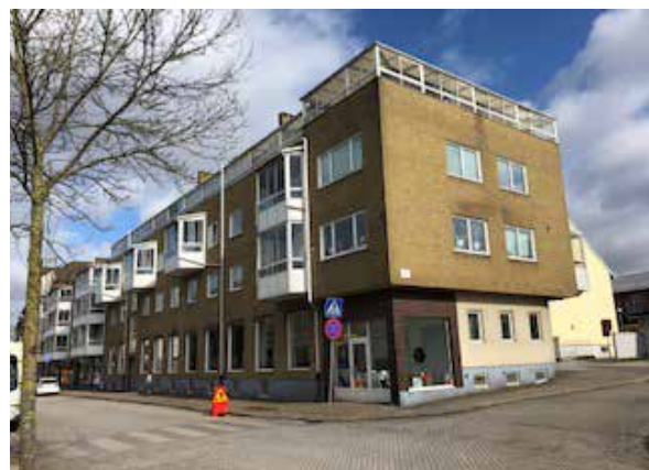
Bokhandlaren 5 vid Södergatan uppfördes cirka 1950. Byggnaden har 3 våningar med en indragen 4 våning som i efterhand (troligen efter 1990) har blivit inglasad vilket har förvanskats byggnaden.
