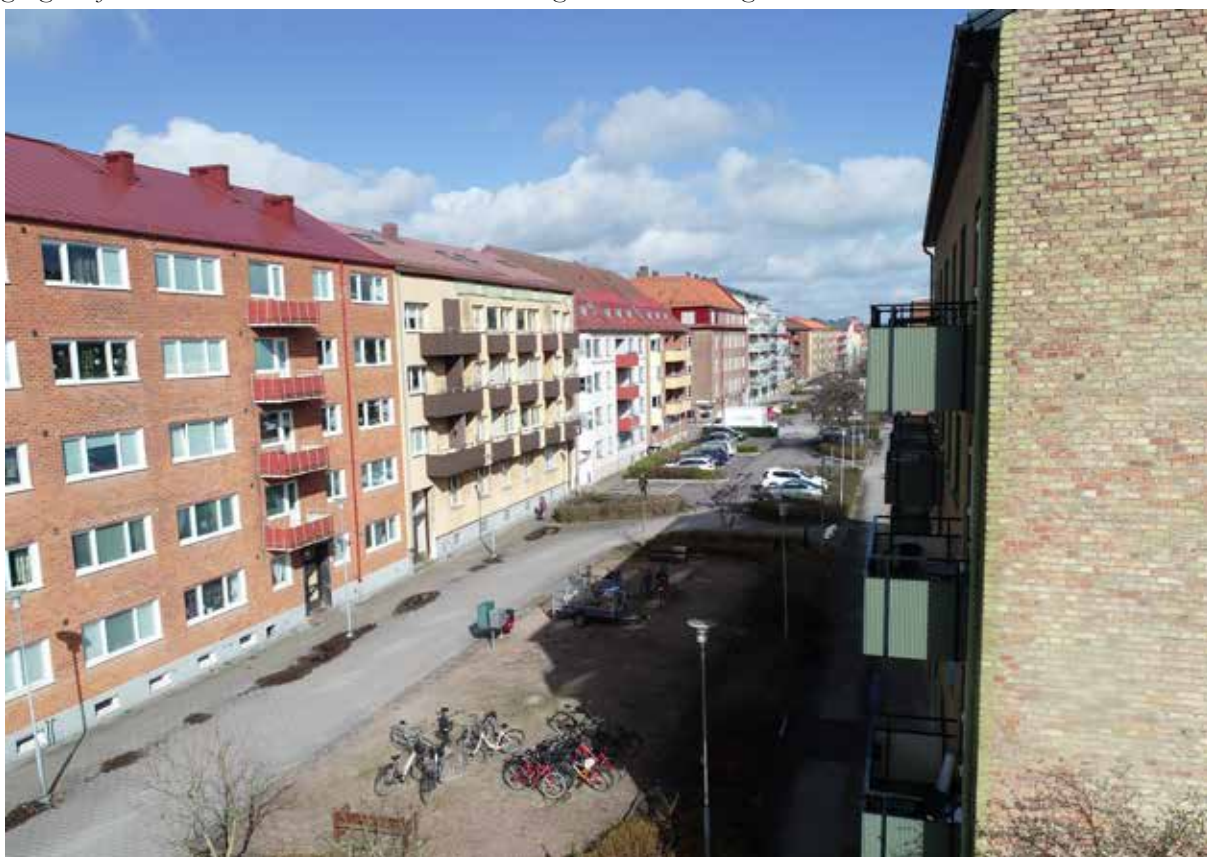
Närmast från vänster Skomakaren 20 och 11. Skomakaren 20 uppförd ca 1960 med rött tegel. Skomakaren 11 med gul puts, uppförd ca 1940. Med lägre rumsböjd har Skomakaren 20 uppförts med ytterligare en våning jämfört med Skomakaren 11. Detta trots att skillnaden mellan byggnadernas nockböjd endast är cirka 1 meter.
