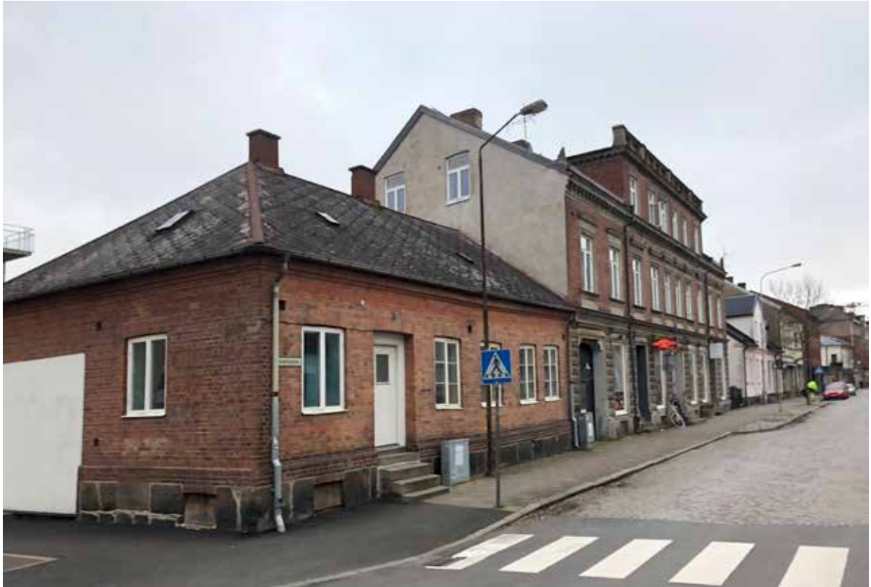
Det sydöstra hörnet av Färgaren 20 är Eslövs gamla brandstation. Ett karaktäristiskt gatbus uppfört under 1890-talet. Byggnad med stort kulturhistoriskt värde för den befintliga stadsbilden enligt Bevaringsplan 1984.
