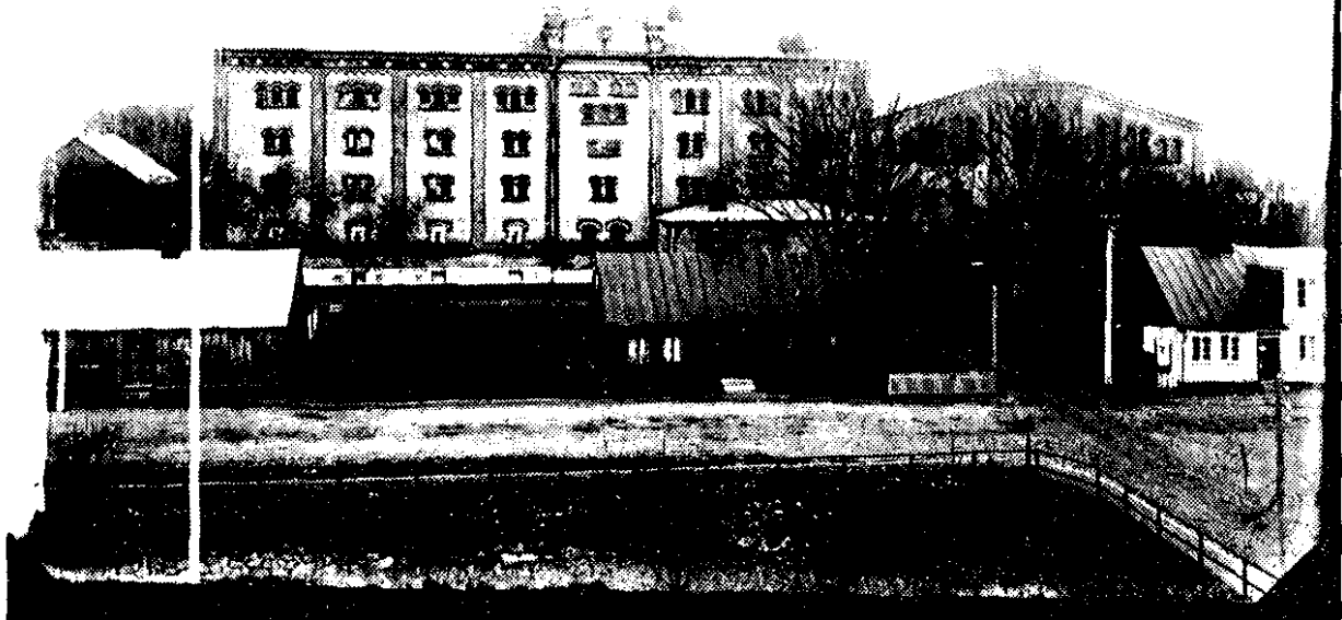
Eslövs bryggeri vid Västerlånggatan västra sida. Grundlagd 1883. Byggnaderna revs i samband med tillkomsten av HSB:s bostadsnäs 1963. (Föjers foto).
