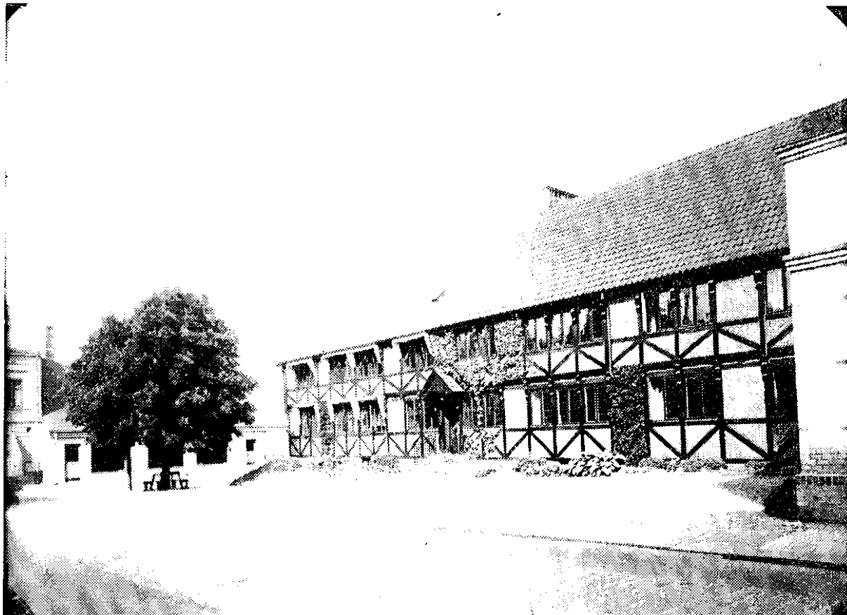
Storgatan 1, Carl Engströms sädesmagasin från 1860-talet som efter en ombyggnad 1913-1918 blev företagets kontorshus.
