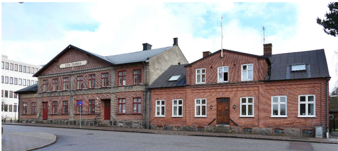
Åkermannen 10 (Kulturskolan) och Åkermannen 8 längs med Södergatan utgör den äldsta bebyggelsen i området och båda är utpekade som kulturhistoriskt värdefull bebyggelse av kommunen. Till vänster mot norr skimtar Medborgarhuset med sina ljusa putsfasader.
