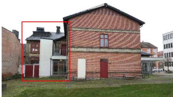
Fasad mot öster där Kulturskolan byggs på.
