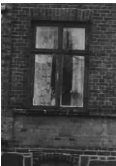
Vänster foto från 1970-talet visar ursprungligt fönster. Idag är fönstren utbytta till nya, utformade likt de ursprungliga med korspostindelning och utåtgående bågar.
