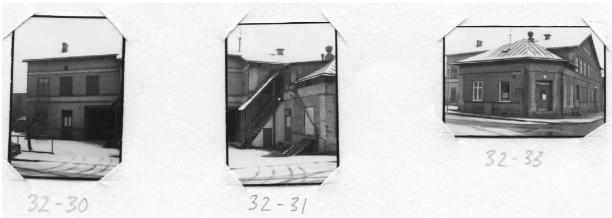
Fotografier från inventering i slutet av 1970-talet. T.v. syns gårdsflygelns norra fasad med portgång. Två fönster på andra våningen är igensatta. Bilden till mitten visar trappan som ledde upp till andra våningen, med ett skärmtak. Källaringång. Bild t.h. visar hörnet med butikslokal vars skyltfönster i enlufts tillkom på 1940-talet, tidigare satt fyrlyfts likt övriga fönster.
