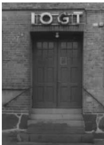
Entrédörr fotad i slutet av 1970-talet, i ett annat utförande än ursprungliga med glasrutor upptill och fyra speglar nedtill.
