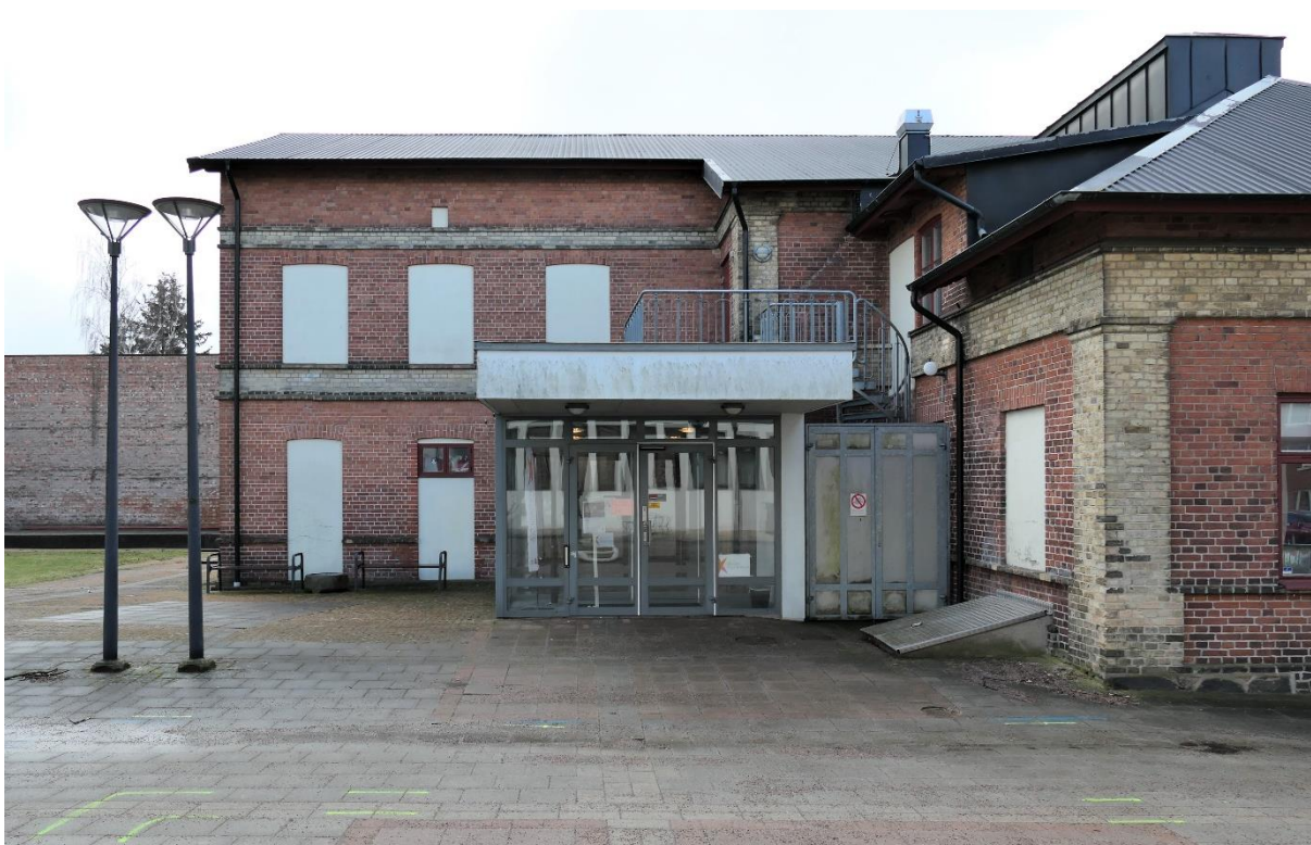
Vy mot söder och gårdsflygel med tillbyggnad i glas från 1990-talet. Igensatta fönster- och dörröppningar.
