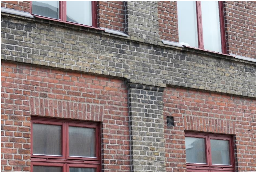
Fasaderna i rött tegel med pilastrar och gesimser i gult tegel.
