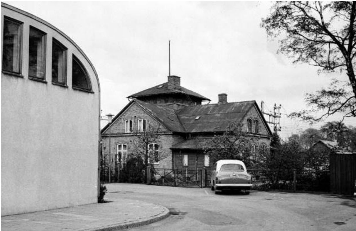
Länsdjurläkare M. G. Fältströms villa, senare kontorsbyggnad åt Åkermannen. Fotot från 1960-talet. Bildkälla: Eslövs bildarkiv, KG-pessfotos bildsamling.
