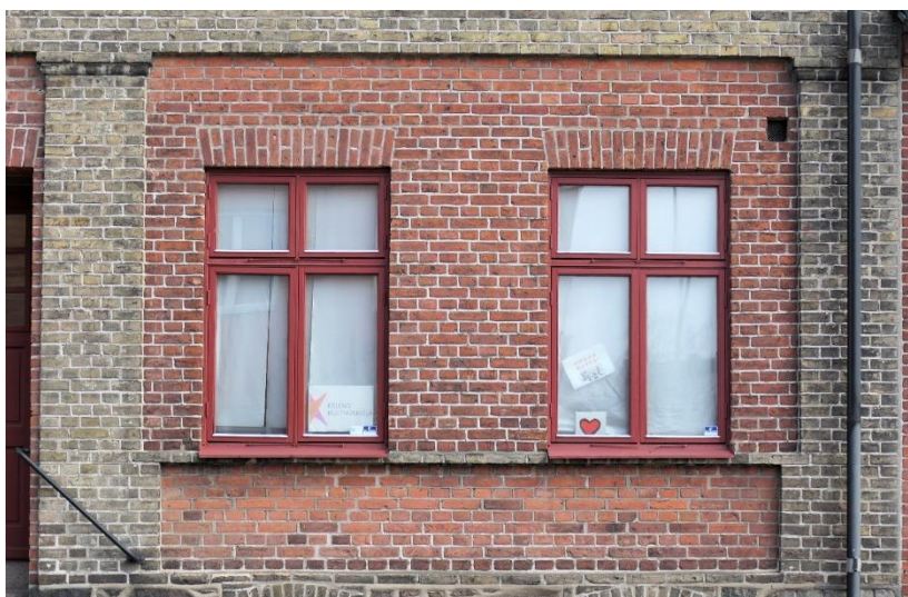
Vänster foto från 1970-talet visar ursprungligt fönster. Idag är fönstren utbytta till nya, utformade likt de ursprungliga med korspostindelning och utåtgående bågar.
