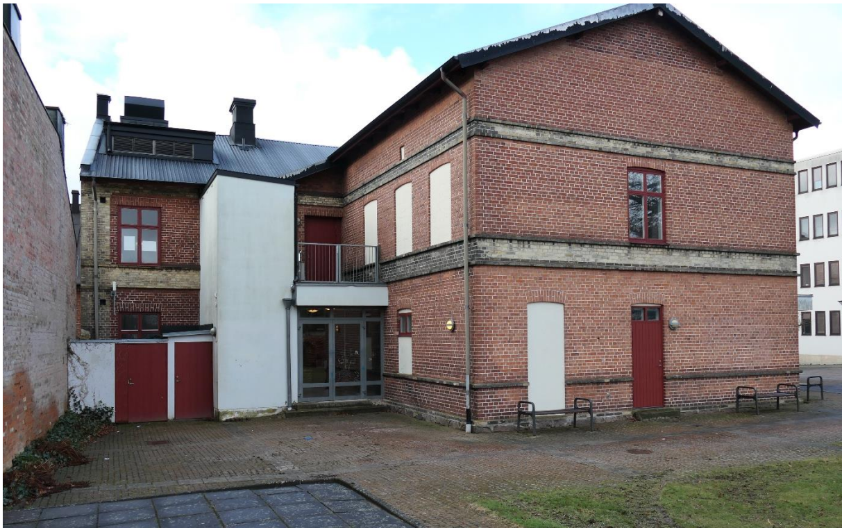
Sydöstra sidan av byggnaden som vetter mot gården. Här finns tillbyggnad samt ett hisschakt. Söder om hisschaktet finns en ingång till källare samt ett miljörum utan tak. Muren till höger hör till grannfastigheten.
