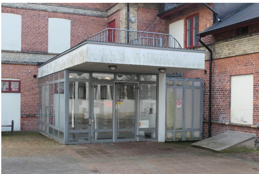
Tillbyggnad mot gårdsflygel består av glasade partier av aluminium med ett tak och skärmtak i betong belagt med takpapp.
