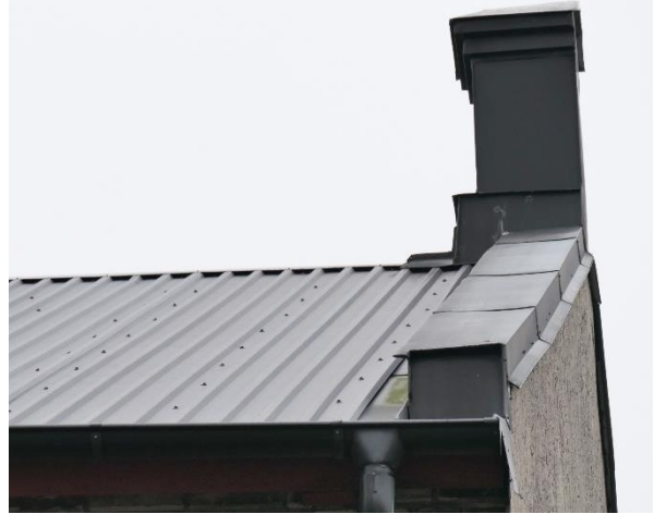
Ursprungligen var taket täckt med papp, bild t.v. från ca 1909. Idag är taket klätt med korrugerad plåt.
