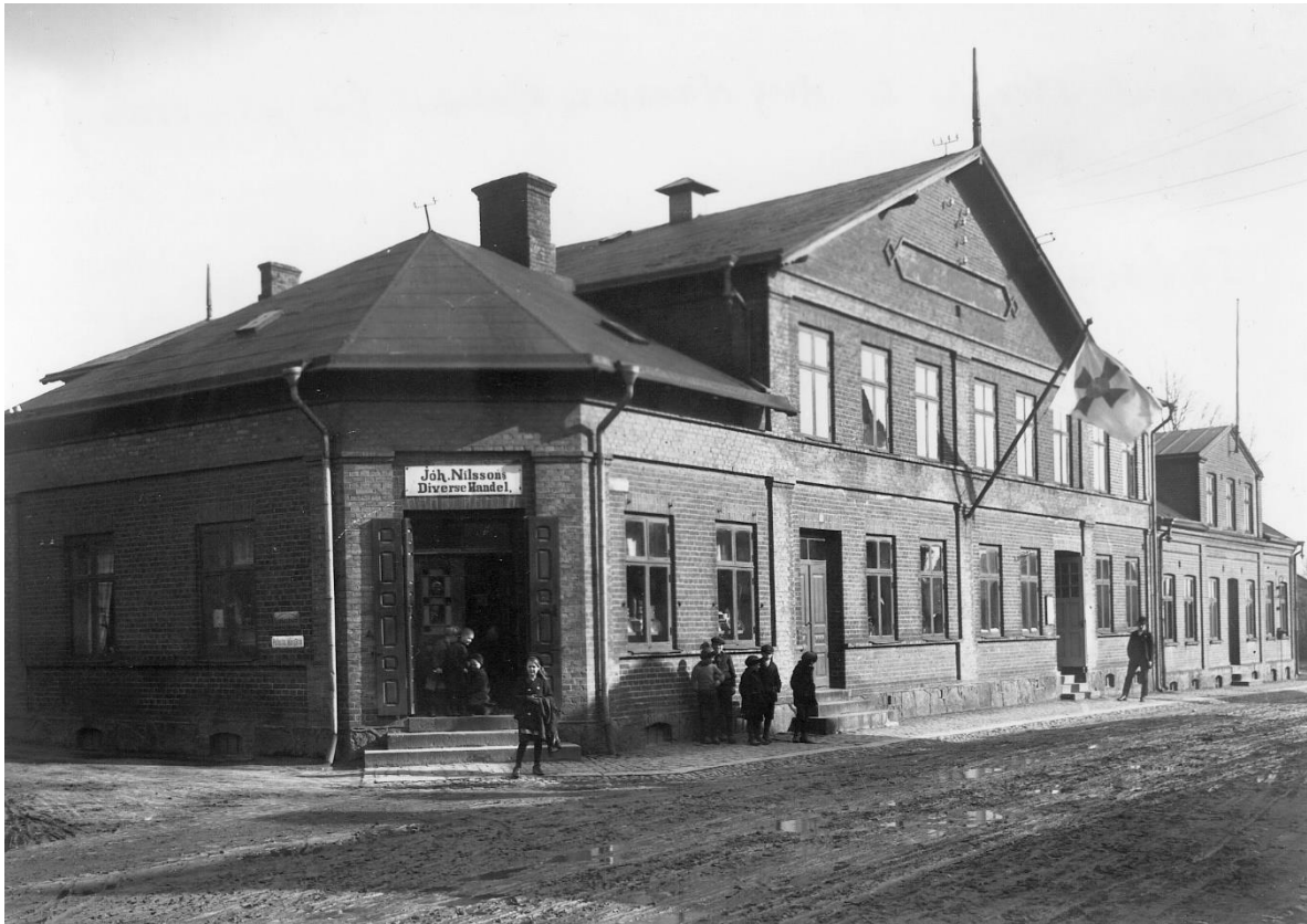
Foto tidigt 1900-tal, efter 1911 då våningen åt söder har höjts. Taknocken över gavlarna åt öst och väst har en profilerad spira, nedanför på gatufasaden är IOGT-flaggan hissad. Butikslokalen nyttjas av Johan Nilssons Diverse Handel. Bildkälla: Eslöfs museum.
