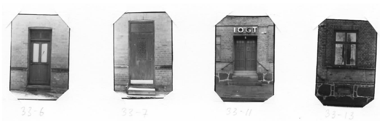
Dörrar och fönster, från vänster; 1. Dörr på gårdsflygelns norra fasad, glasad överdel med överljus. 2. Dörr på gårdsflygelns östra fasad, även den glasad med överljus men med gjutet glas, från 1900-talets mitt. 3. Södra entrédörren mot Södergatan, en pardörr med spröjsat glas upptill och stående, rektangulära fyllningar nedtill. 4. Fönster mot gatan.
