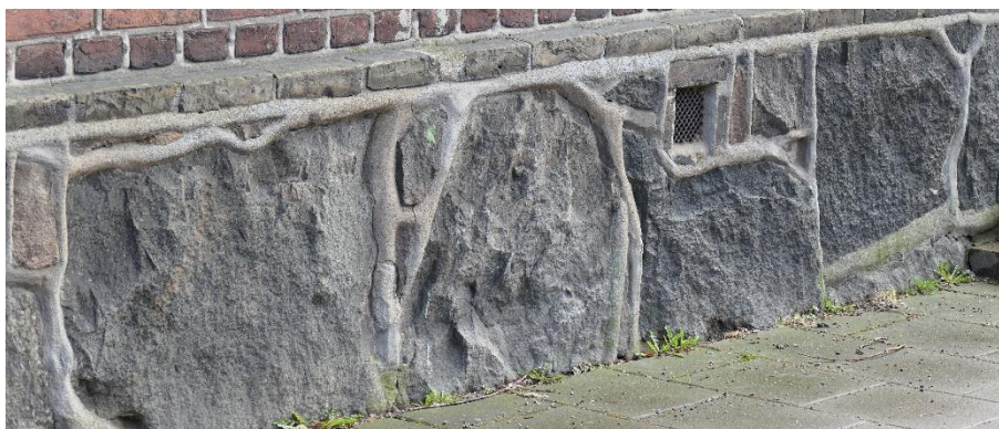
Sockel av natursten med den karakteristiska utanpåliggande fogen.
