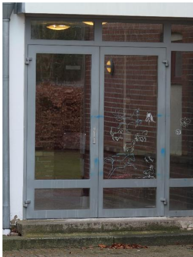
Glasdörrar från 1990-talet på gårdssidan.
