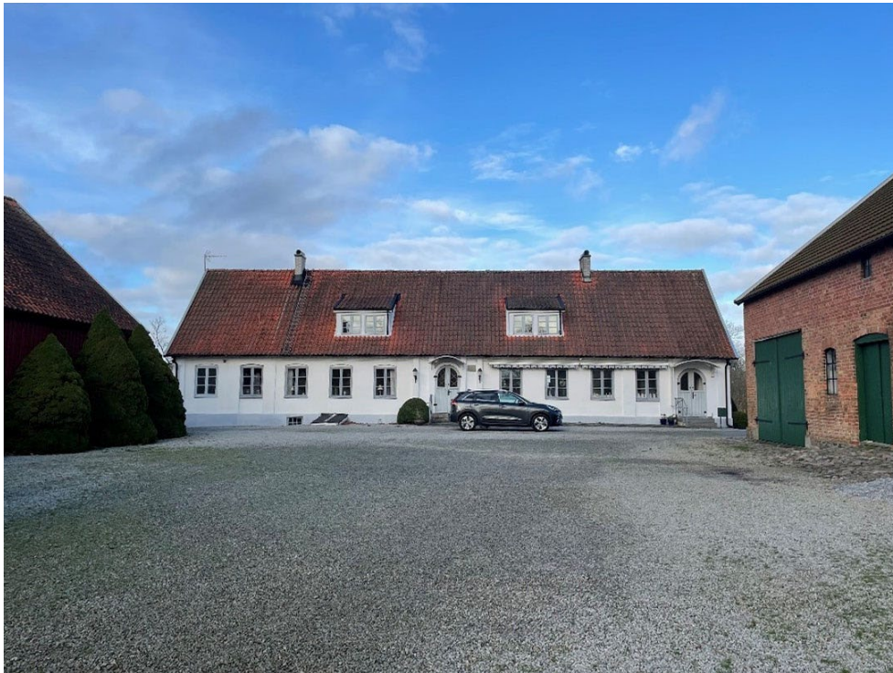
Figur 8. Mangårdsbyggnaden och gårdsplanen sett från söder.
