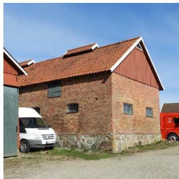
Svinstallets södra fasad och östra gavel.
