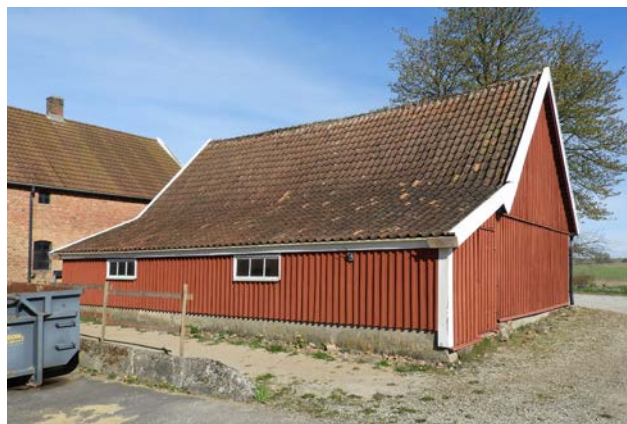
Traktorgaraget sett från söder.
