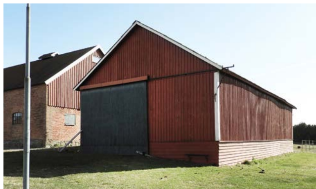
Maskinhallen. Gavel mot väster och långsida mot söder.
