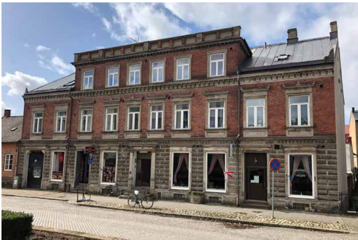
Färgaren 20 är ett gathus i två våningar med frontespis som uppfördes cirka 1895. Huset är förvanskat med stora butiksfönster, moderna fönster och dörrar. Byggnad med stort kulturbistoriskt värde för den befintliga stadsbilden enligt Bevaringsplan 1984.
