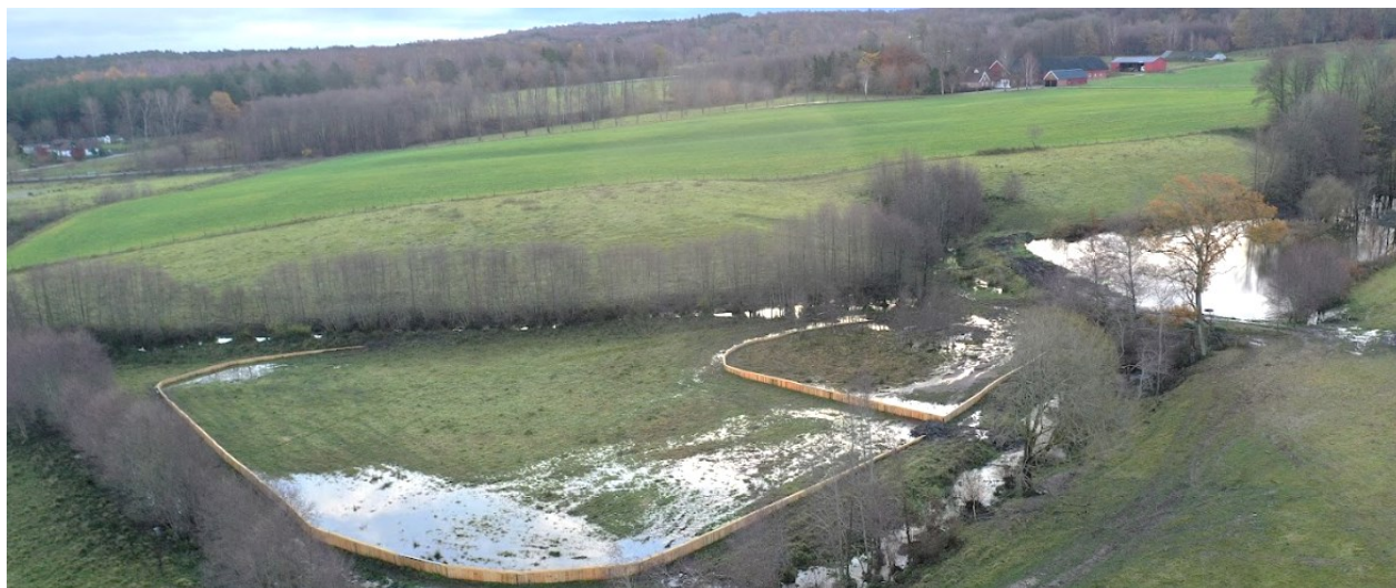
Vy över en pilotanläggning med plankdämmen utanför Veberöd i Lunds kommun. Vid högflöden avleds vatten från uppströms damm till en betesmark där vattnet hålls kvar av plank. Denna lösning fungerar bra tillsammans med betande djur. Foto Karl Asp
