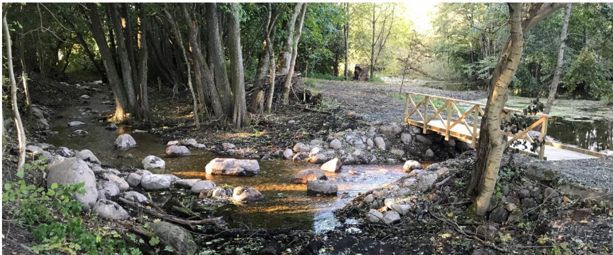
Ett omlöp har anlagts från kvarndammen vid Högseröd som bidrar till fria vandringsvägar för fisk och andra vattenlevande djur.
