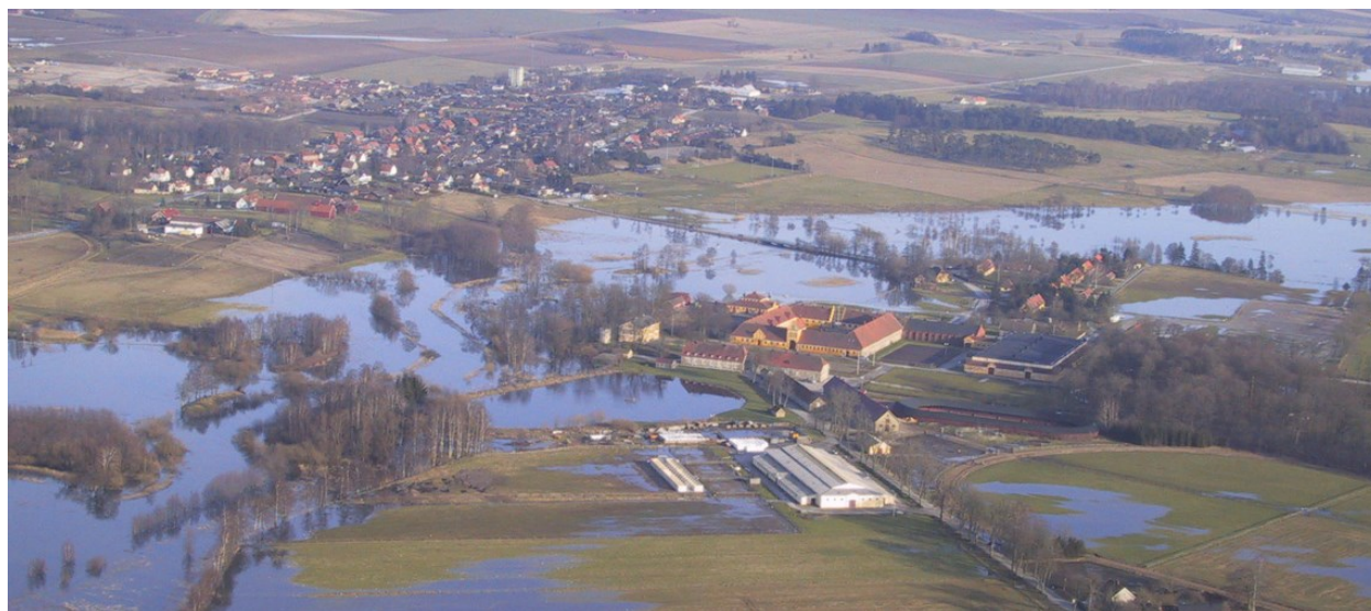
Plats för vatten behöver planeras för i Kävlingeåns avrinningsområde. Vy över översvämning i Kävlingeåns dalgång vid Flyinge 2024
