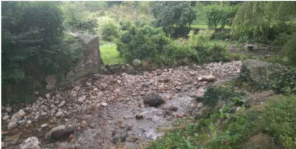
Figur 3.14: Vid Skönadals kvarn i Harlösa har ett vandringshinder för fisk och andra vattenlevande organismer rivits ut inom ramen för arbetet med Kävlingeåns vattenvårdsprogram. På bilden syns den återställda bäckfåran och rester av kvarndammen.
