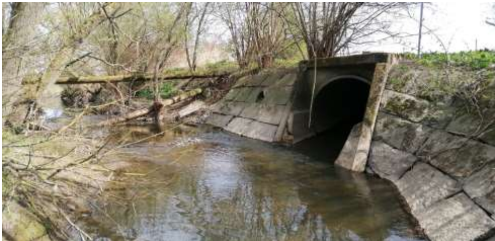
Figur 4.9: Strax öster om Östra Asmundtorp mynnar en kulvert i Långgropen. Kulverten leder dagvatten från stora delar av norra Eslövs tätort till Långgropen.
