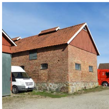
Svinstallets södra fasad och östra gavel.
