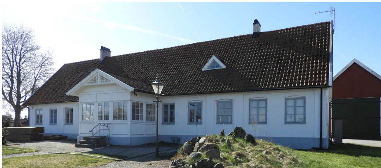
Mangårdsbyggnadens fasad mot trädgården i norr.
