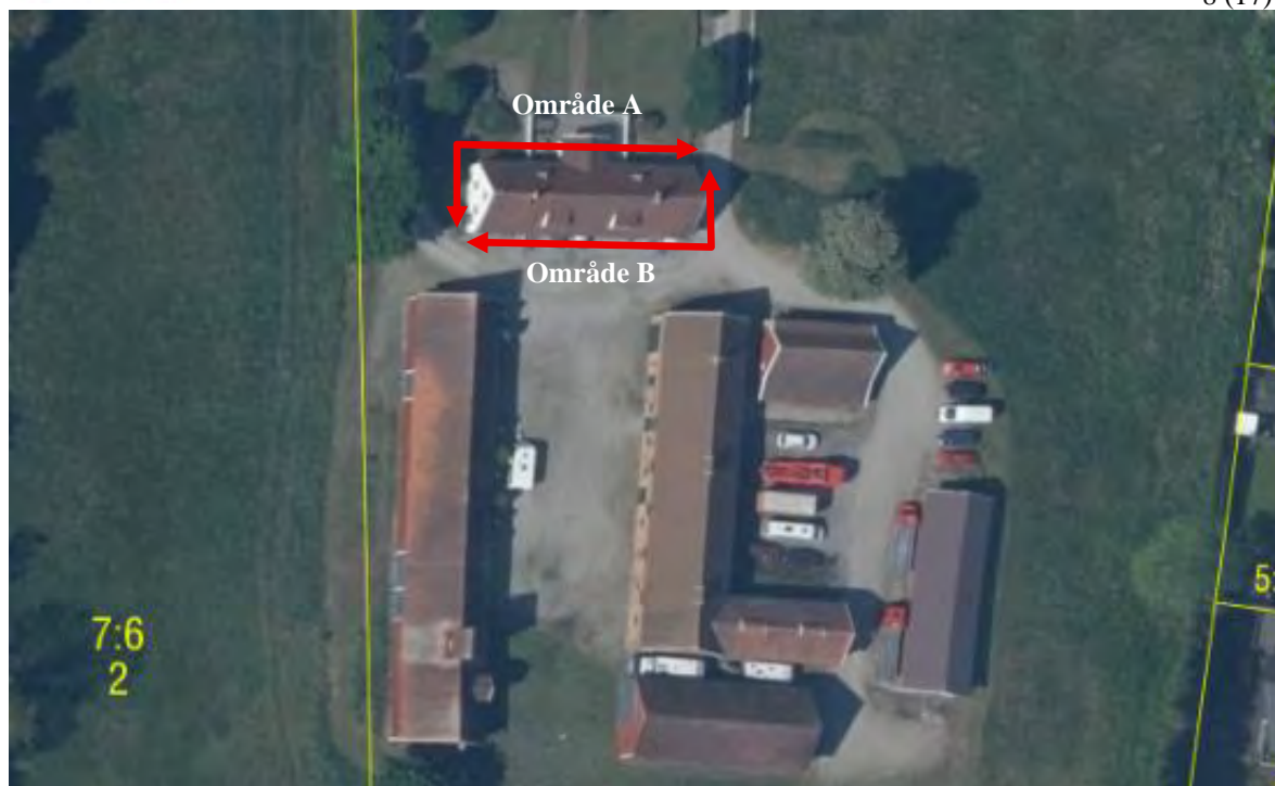
Figur 3.1 Schematiskt överblick över området runt mangårdsbyggnaden där provtagning med handhållen spade har utförts. Provgropar har grävts för att ta ytliga jordprover (ca 0–0,3 m) med syfte att analysera PCB-halter. Samlingsprover har sedan tagits fram och analyserats för områdena A respektive B. Källa: Lantmäteriet.
