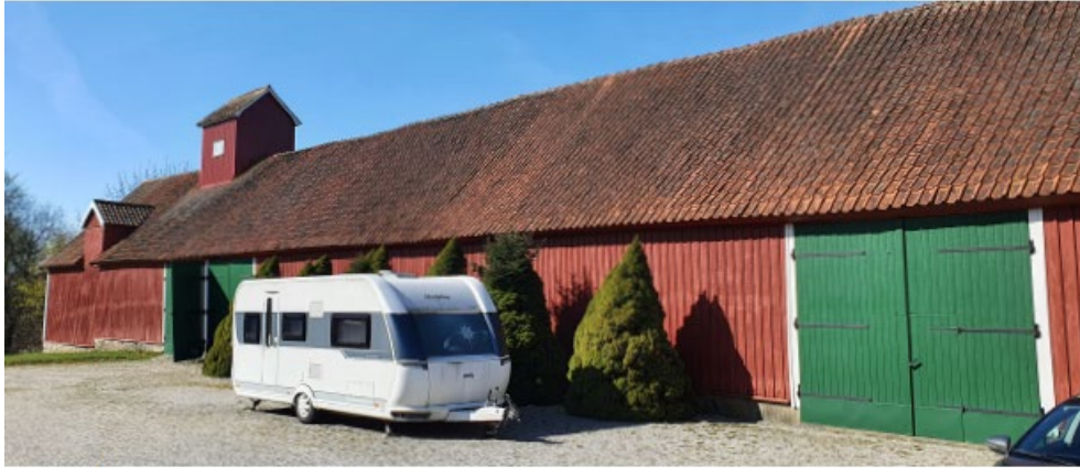
Figur 11. Logen sedd från nordöst. Bild från kulturmiljöutredning.
