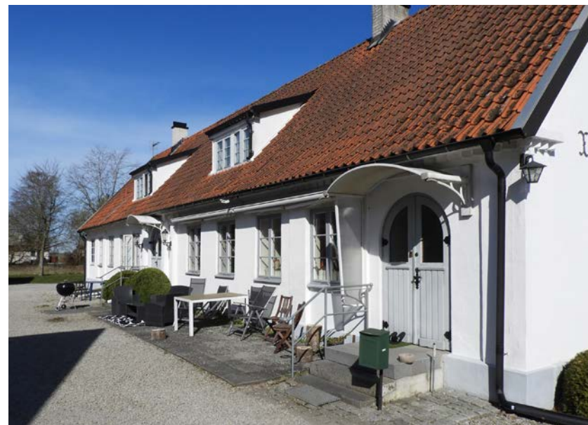
Gårdsfasaden med sidoentrén närmast i bild.
