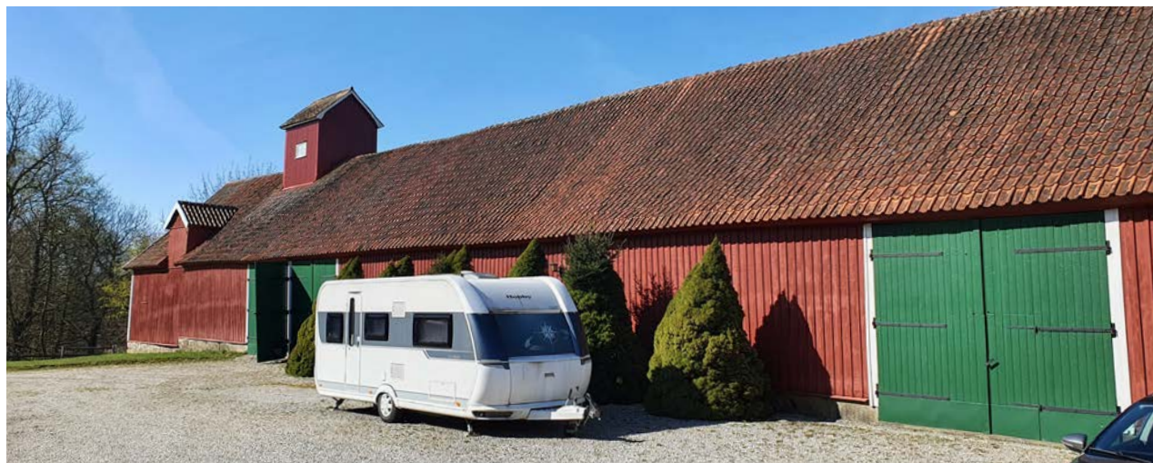
Logens fasad mot gårdsplanen.
