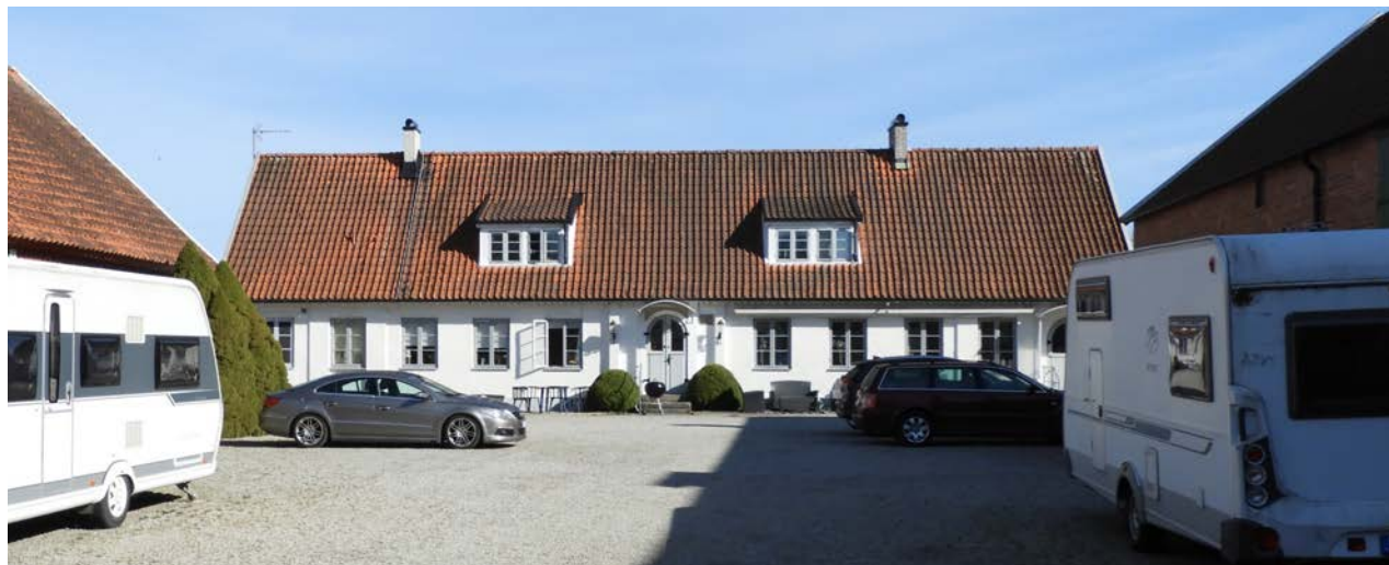
Mangårdsbyggnadens fasad mot gårdsplanen i söder.
