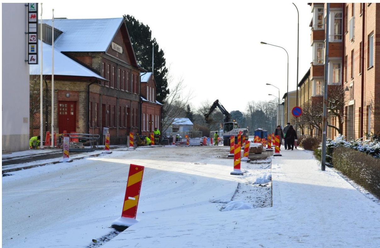
Ombyggnad påbörjad – Södergatan ska bli bussgata!
