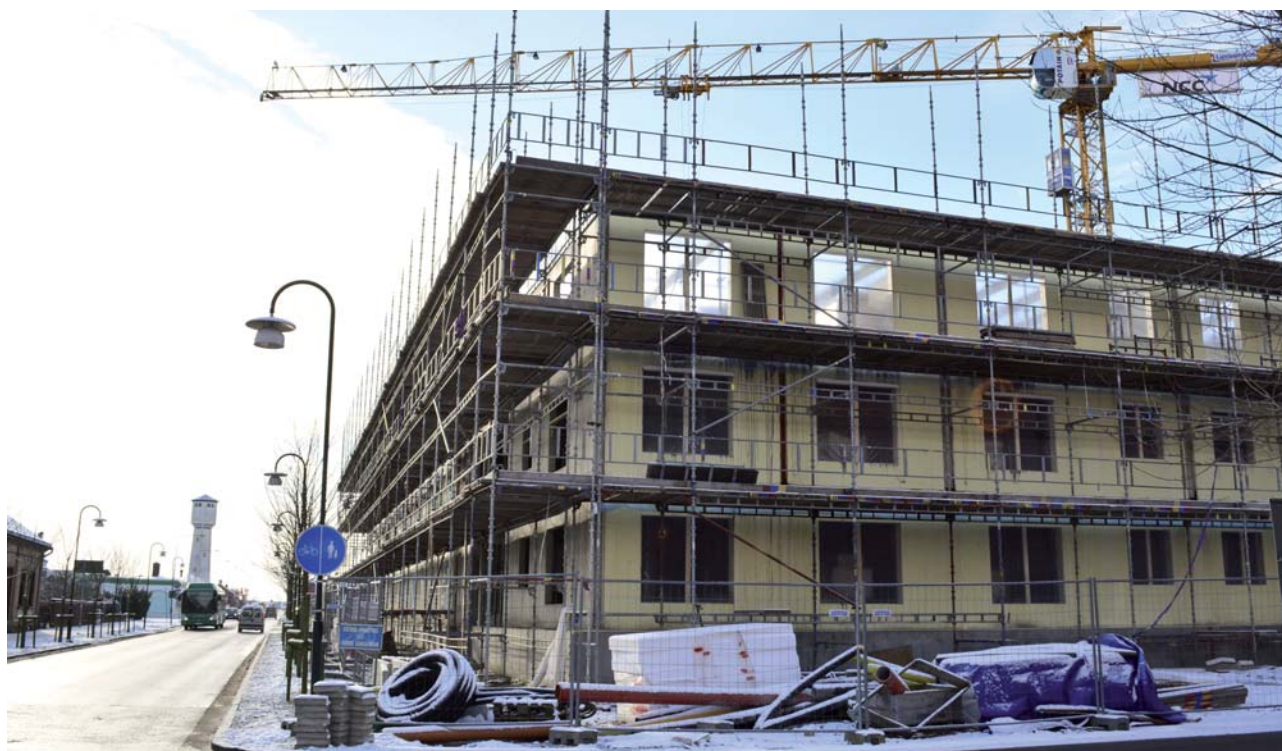
Nya lägenheter byggs vid stationsnära läge i Eslöv.
