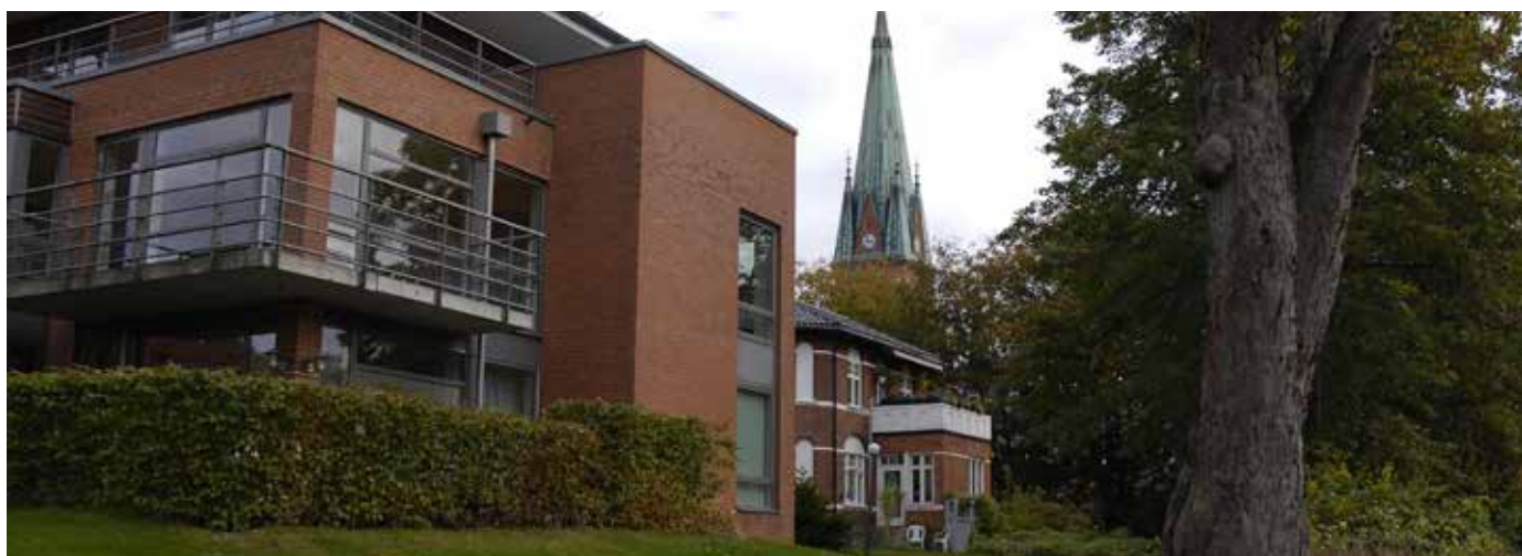
Ebos fastighet vid Sturegatan/Fredsgatan i Eslöv.
